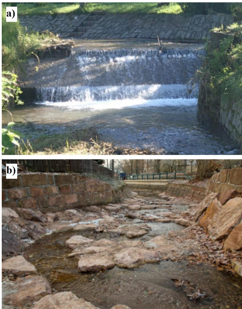
Obr. 10: Bolkovský potok: a) původní koryto; b) po provedené revitalizaci (Křesina 2017).
