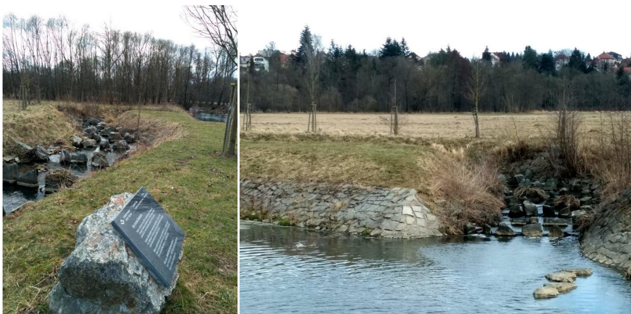
Obr. 9: Realizace rybího přechodu (foto autor 2021)
