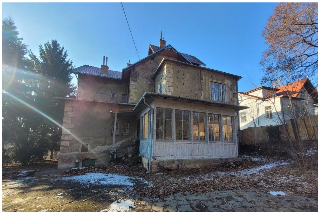
Obrázek č. 8: Severozápadní pohled na objekt před začátkem rekonstrukce
