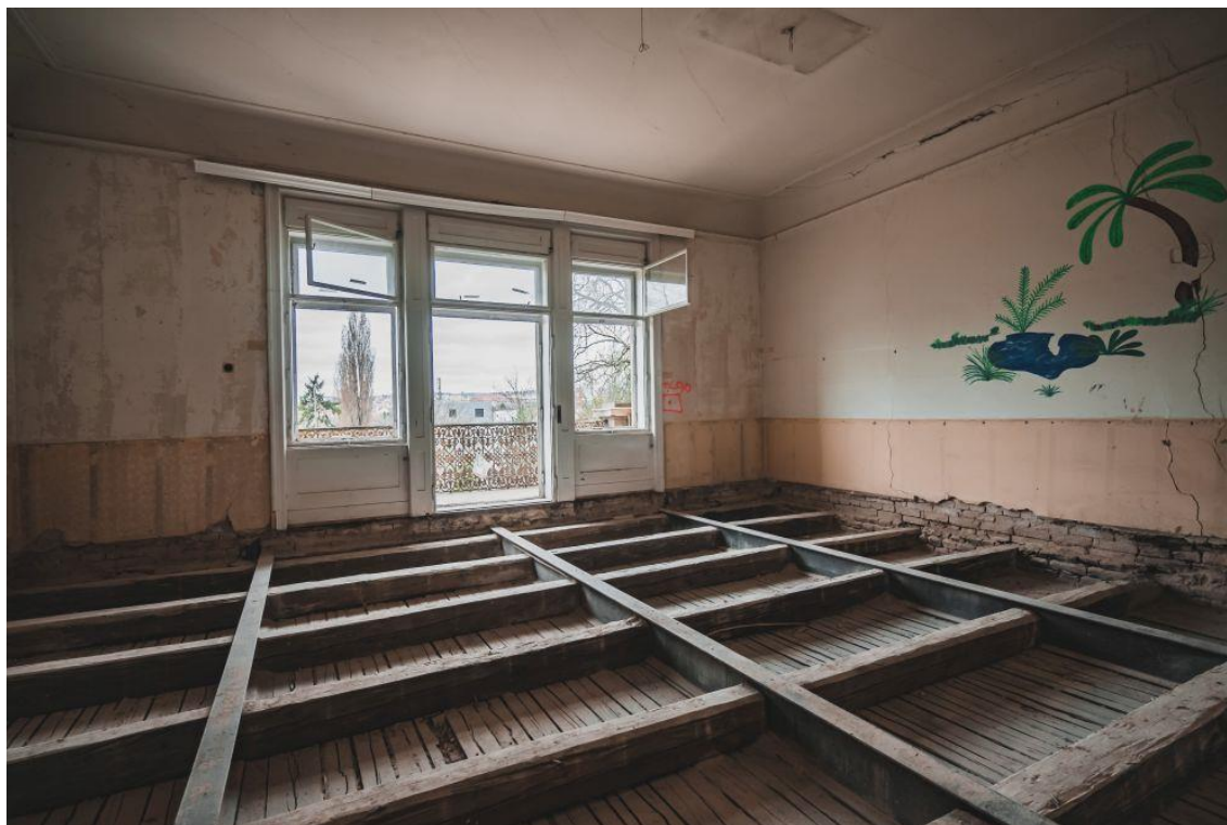
Obrázek č. 14: Probíhající rekonstrukce s viditelnou malbou z doby fungování vily jako mateřské školky 89
