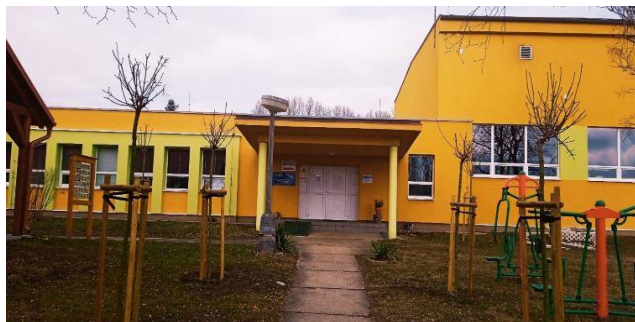
Vchod do budovy školy s nájezdovou rampou
