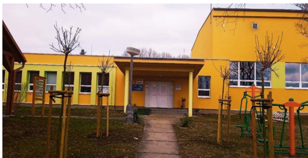
Vchod do budovy školy s nájezdovou rampou
