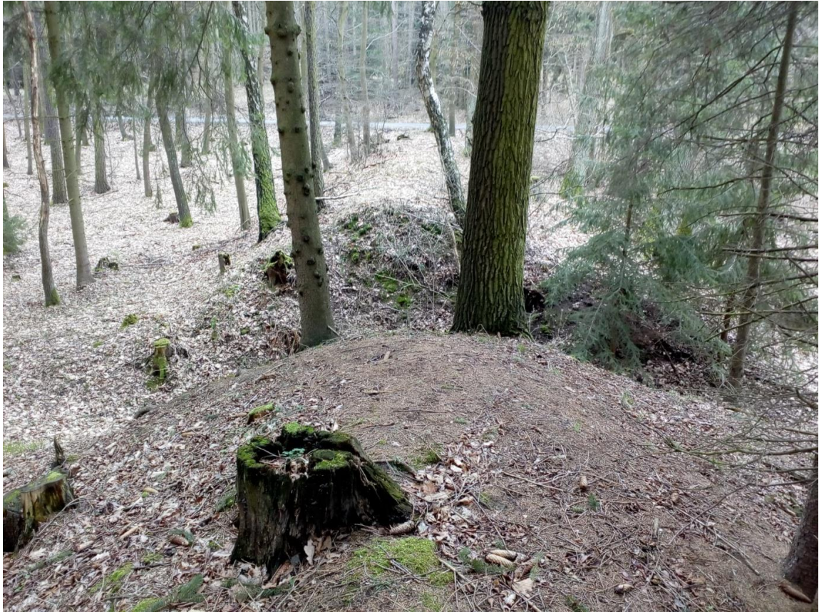
Obr. 21 Hráz rybníka u Náměště na Hané (foto: Hrabalová, J., březen 2017)
