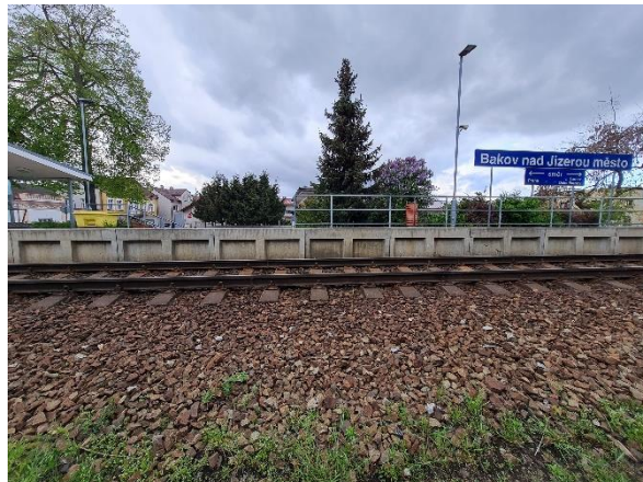
Obrázek 20: železniční zastávka Bakov nad Jizerou město (Zdroj: vlastní fotografie)
