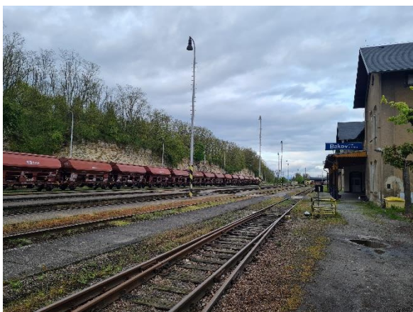
Obrázek 19: železniční zastávka Bakov nad Jizerou (Zdroj: vlastní fotografie)
