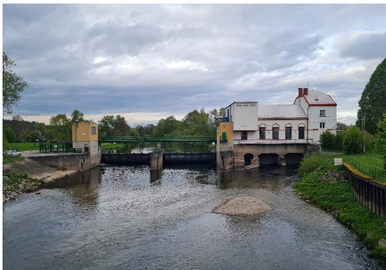
Obrázek 5: Malá vodní elektrárna a jez na Jizeře u Bakova nad Jizerou (Zdroj: vlastní fotografie)
