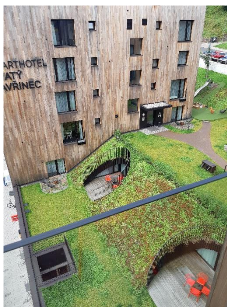
Obrázek 87 Střešní zahrada Aparthotelu Svatý Vavřinec nad garážemi pokrytá travinami a rostlinami z rodu Sedum , komplex má stejně ozeleněné střechy všech
