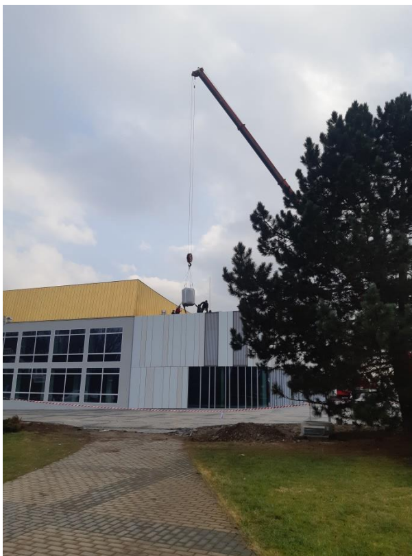
Obrázek 4 Pokládka substrátu na nově vzniklé extenzivní střešní zahradě na aule ČZU, leden 2020
