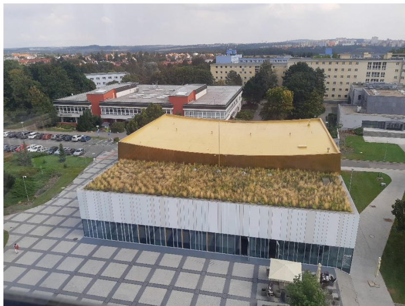
Obrázek 60 Pohled na novou realizaci střešní zahrady na Aule ČZU, září 2021
