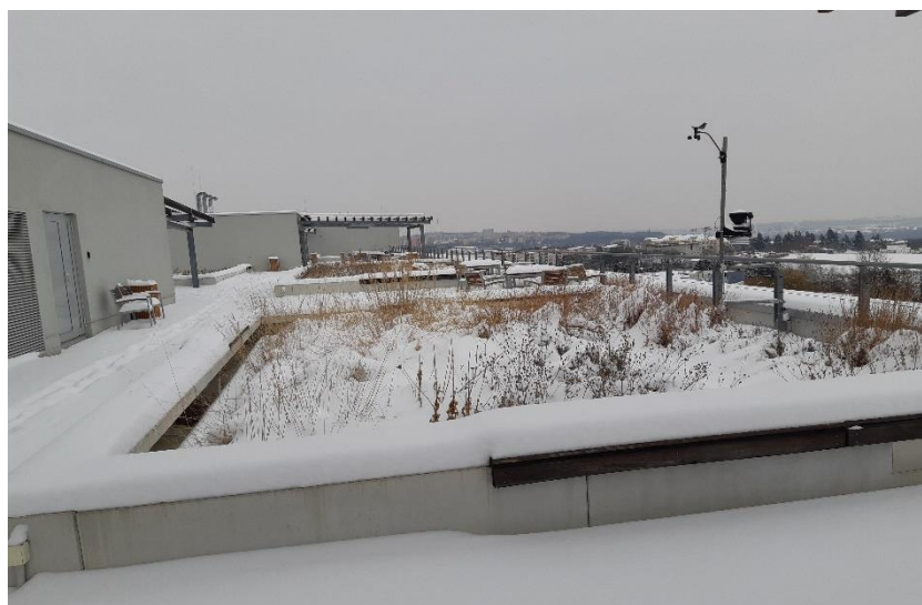
Obrázek 59 Střešní zahrada MCEV II pod únorovou sněhovou pokrývkou
