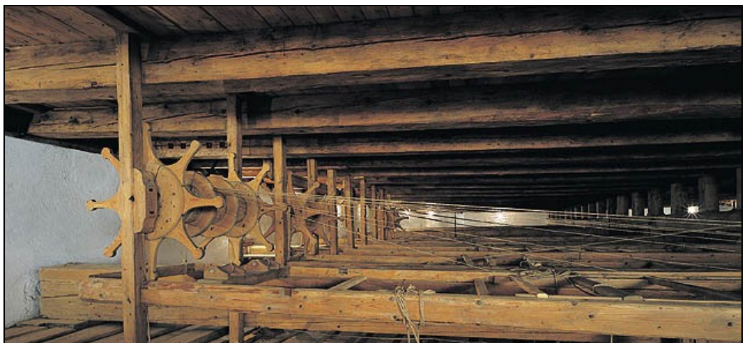
Obr. 14 – Dolní provaziště pod jevištěm zámeckého divadla v Českém Krumlově
