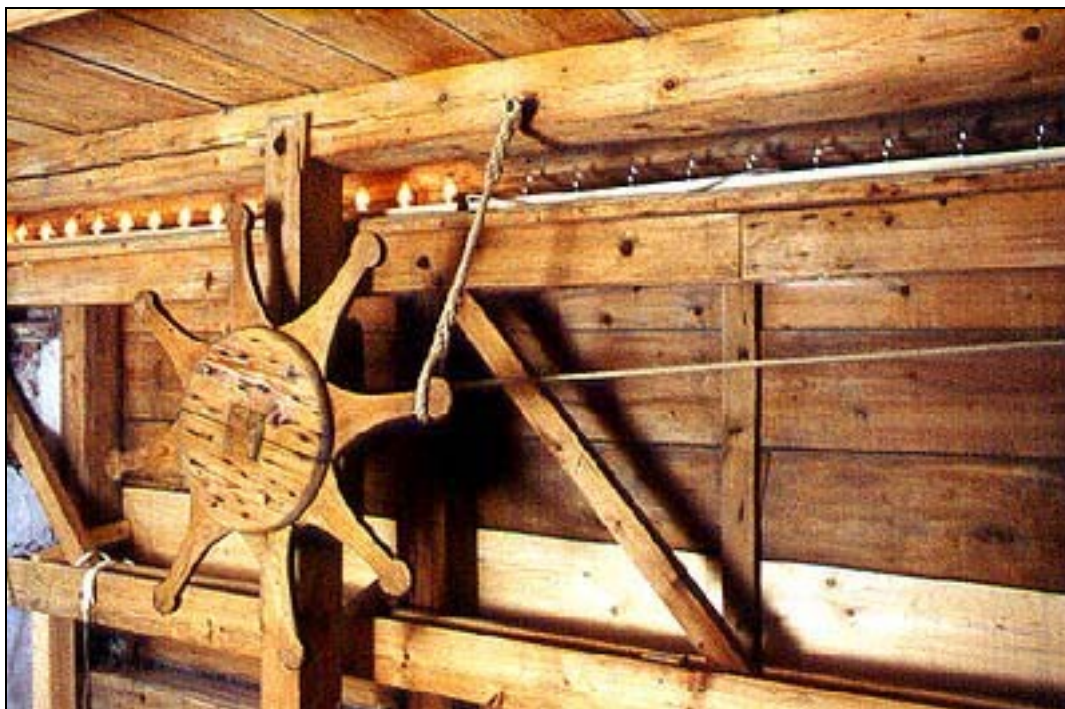
Obr. 15 – Osvětlovací trám pod forbínou zámeckého divadla v Českém Krumlově
