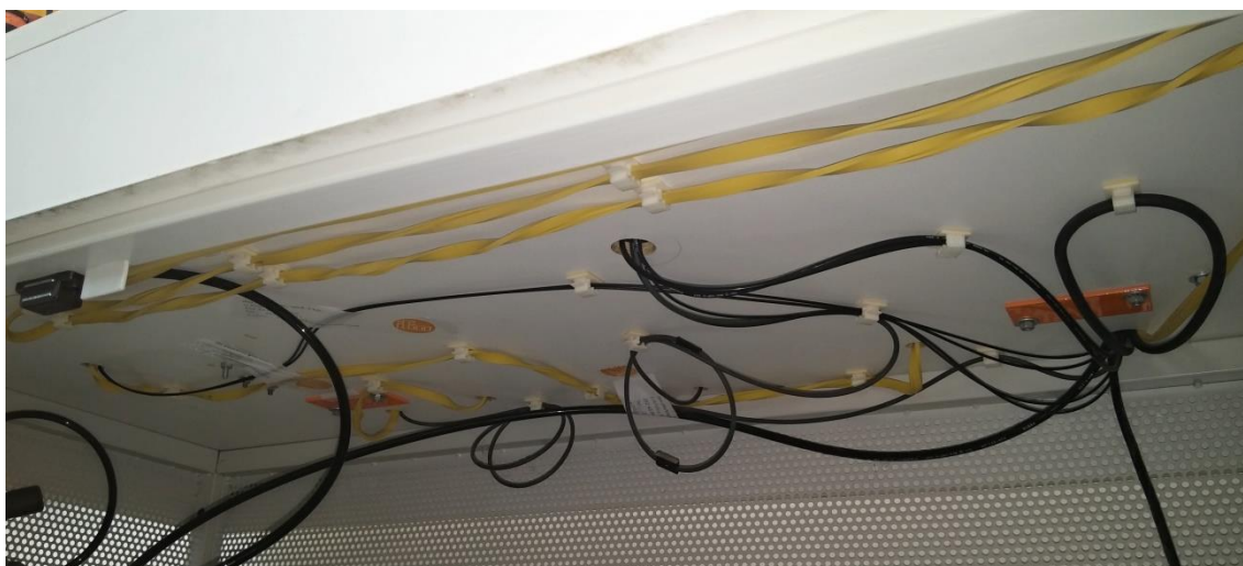
Obr 17 - Upevnění kabeláže
