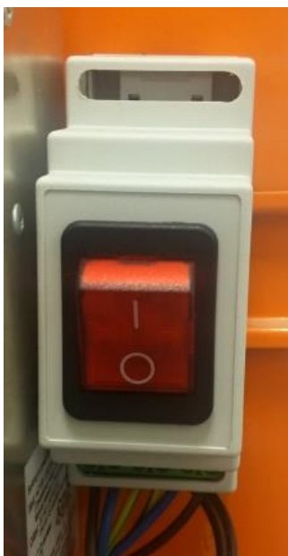
Obr 12 - Hlavní vypínač
