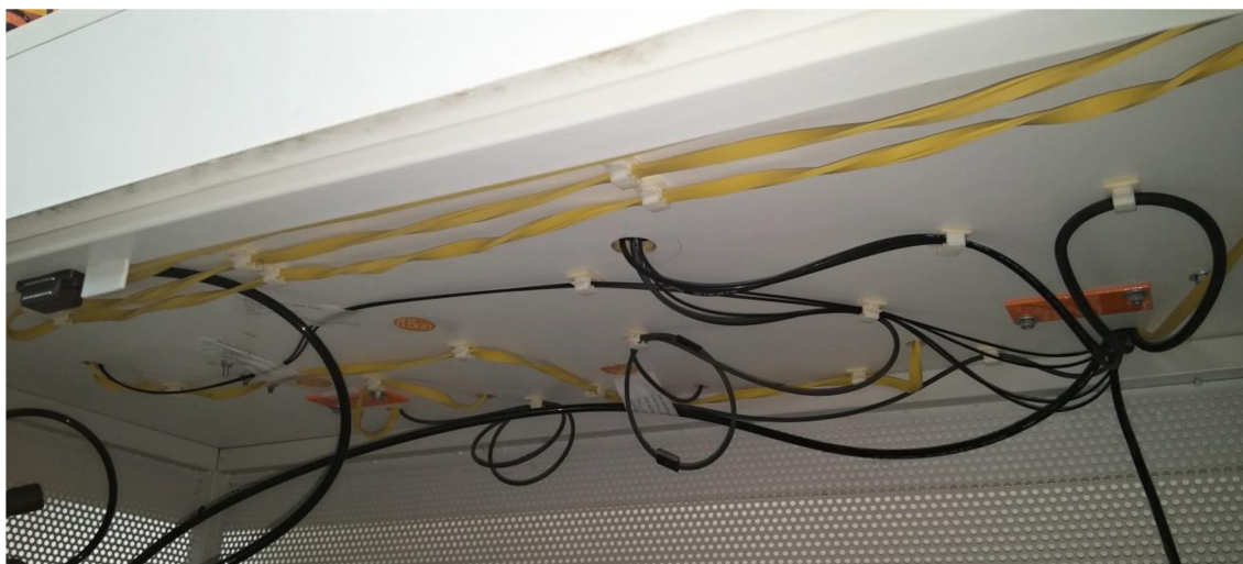
Obr 17 - Upevnění kabeláže
