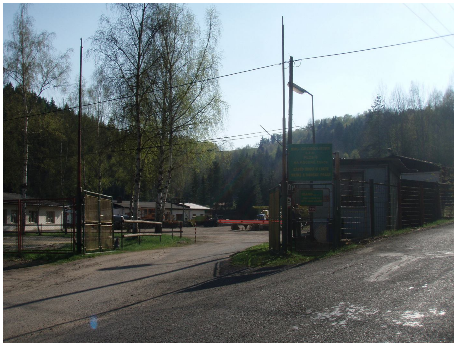
Příloha č. 14 Areál GIS GEOINDUSTRIA, býv. Horní odkaliště Nadlesí
