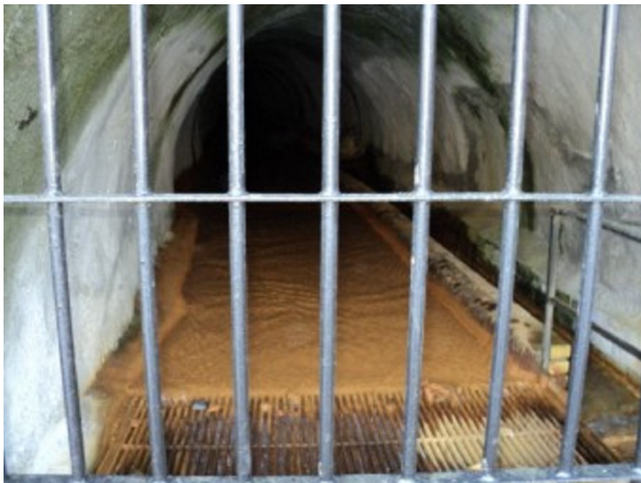
Příloha č. 9 Ústí štoly Barbora - detail
