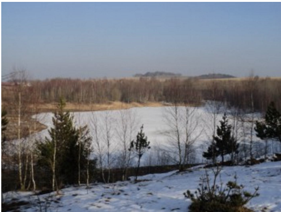
Příloha č. 13 Odkaliště Stannum
