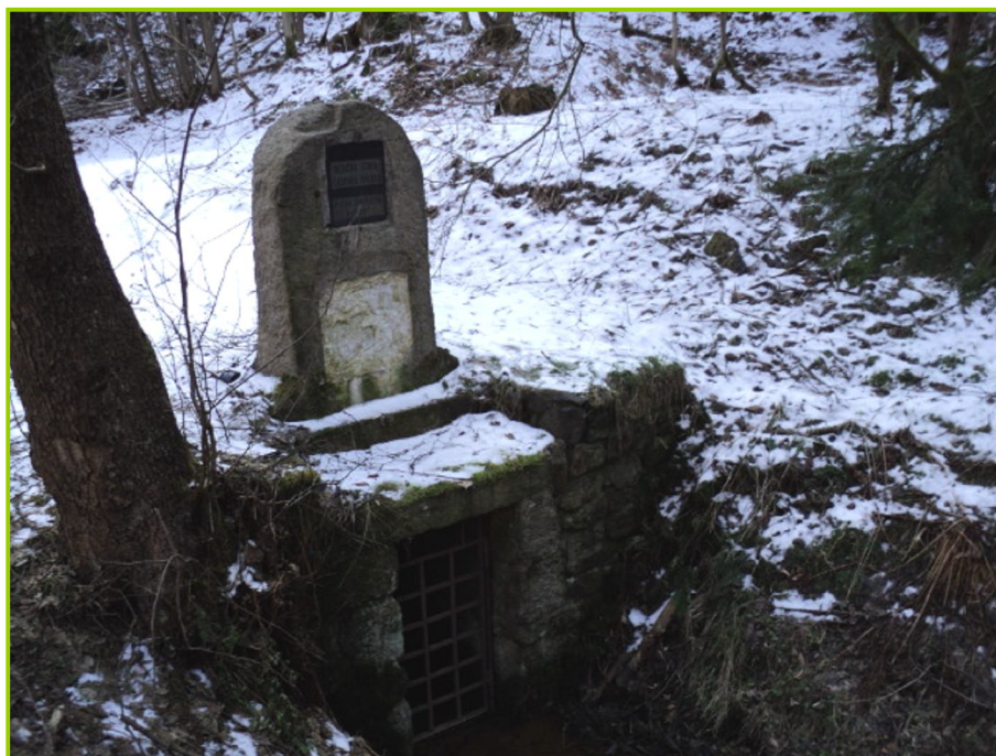
Obr. 9 Portál dědičné odvodňovací Štoly Kašpara Pfluga
