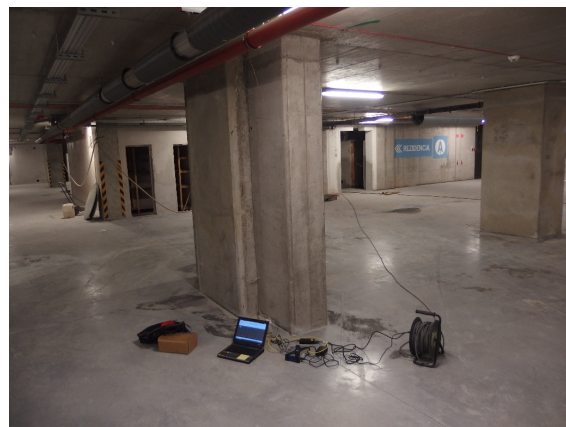
Obr. 6.16 Dlouhodobé měření odporových tenzometrů instalovaných na tyčích
