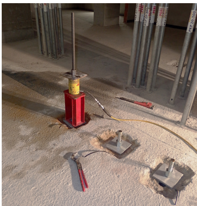
Obr. 6.9 Tahová zkouška dodatečné smykové výztuže pomocí dutého hydraulického lisu
