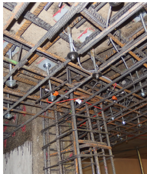
Obr. 5.78 Pohled na osazené tenzometry v armokoši hlavice
