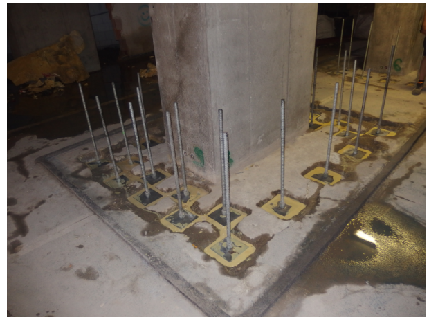
Obr. P 10 Pohled na celkovou sanaci po finálním zainjektování vrtu
