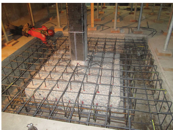
Obr. 2.53 Dodatečná obetonování základové patky [49]
