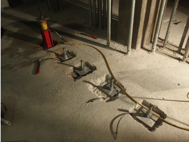
Obr. P 7 Aktivace tyče předeprnutím dutým hydraulickým válcem
