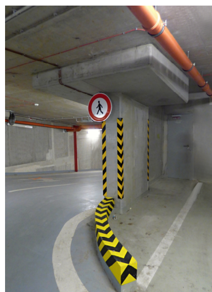
Obr. 5.80 Celkový pohled na dokončenou konstrukci
