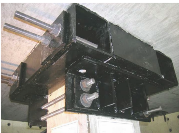
Obr. 2.43 Zesílená konstrukce ocelovou hlavicí [44]
