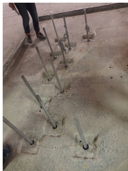
Obr. P 6 Instalované závitové tyče ve vrtech po zalití kořene
