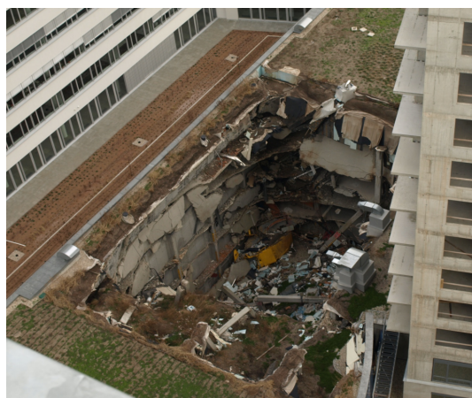
Obr. 2.9 Havárie polyfunkčního komplexu Trinity, Bratislava, Slovensko, 2012 [8]
