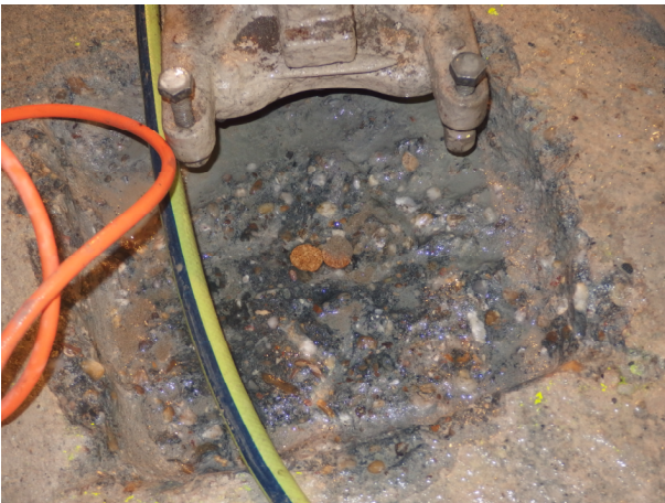
Obr. P 3 Dočasné utěsnění vrtu korkovým špuntem
