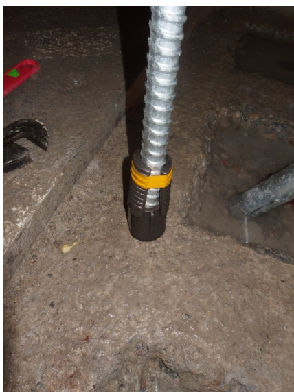
Obr. P 5 Osazený expansion shell na závitové tyči před umístěním do vrtu
