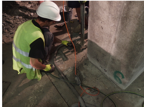
Obr. P 2 Provádění vrtu Ø20mm pro osazení injektážního pakru
