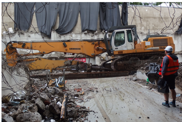
Obr. 5.81 Zatížení sanované stropní desky demoličním bagrem o celkové hmotnosti 59,4t
