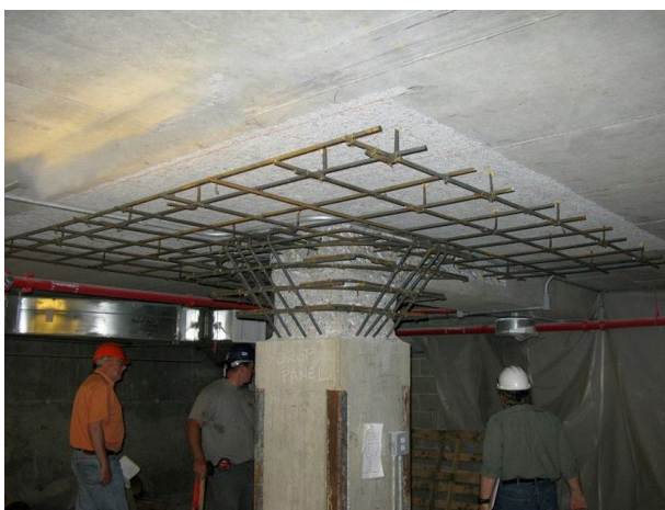
Obr. 2.49 Pohled na výztuž v jedné vrstvě dodatečné betonové hlaviče [48]
