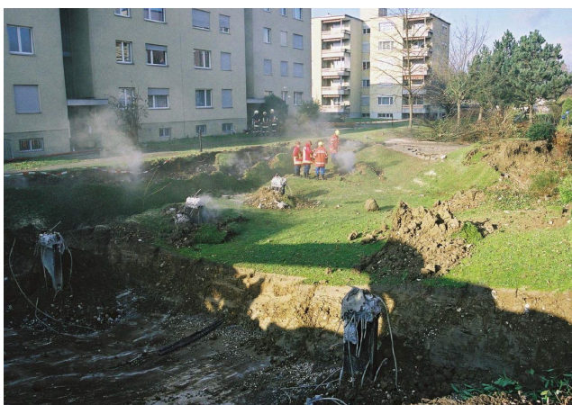
Obr. 2.8 Havárie podzemních garáží Gretzenbach, Švýcarsko, 2004 [7]
