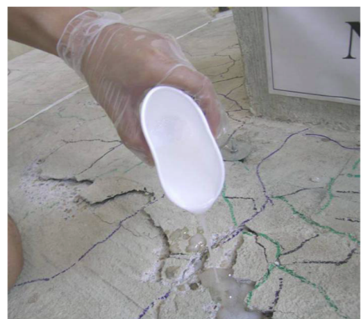
Obr. 2.44 Zalévání smykové trhliny v porušené desce epoxidovou pryskyřicí před zesílením ocelovou hlavicí [44]
