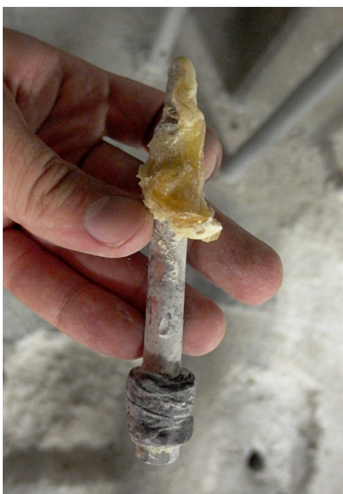
Obr. 6.8 Použitý injektážní pakr pro předtěsnění oblasti pod základovou deskou
