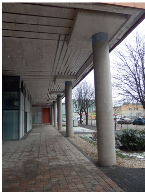
Obr. 2.45 Dodatečná betonová hlavice umístěná na původní sloupu (foto archiv autora)
