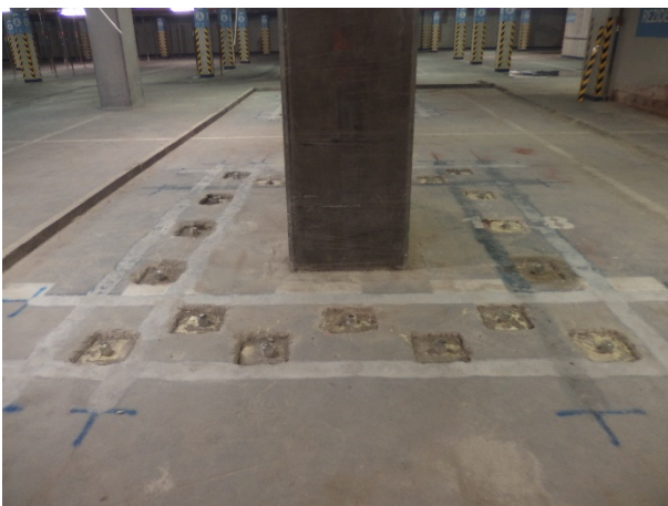
Obr. P 11 Pohled na celkovou sanaci po zakrácení tyčí těsně nad kotevní matku
