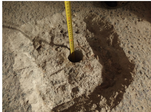
Obr. P 4 Vyvrtaný otvor velkého průměru pro osazení tyče s expansion shellem
