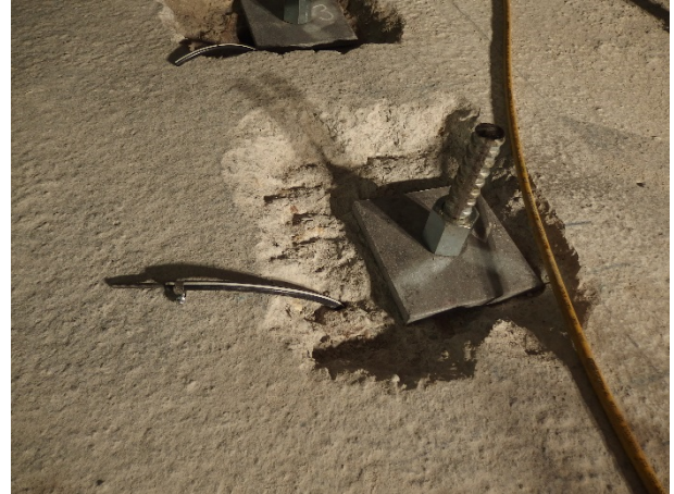
Obr. P 8 Pohled na kotevní desku s vývodem injektáže šikmým vrtem
