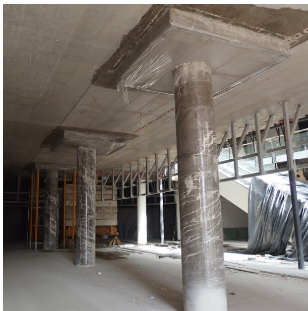
Obr. 2.46 Dodatečná betonová hlavice umístěná na obetonovaném sloupu (foto archiv autora)
