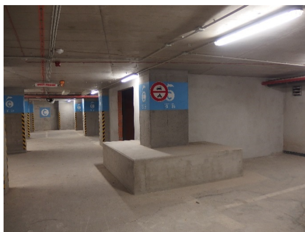
Obr. 2.54 Dodatečná „obrácená“ betonová hlavice na základové desce (foto archiv autora)
