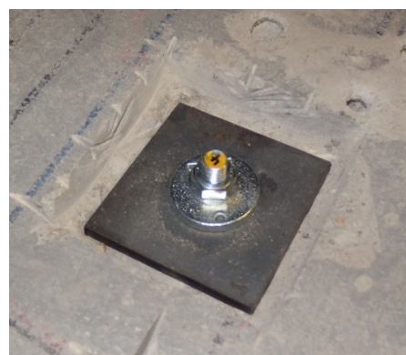
Obr. 5.70 Podložka 90/90/6 mm s dynamickým setem Hilti na horním povrchu desky
