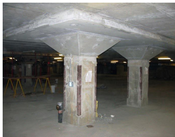
Obr. 2.50 Pohled na vybetonovanou konstrukci dodatečné hlaviče [48]
