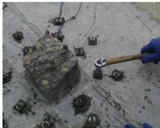
Obr. 2.36 Konstrukce po opravě protlačeného kužele včetně nainstalovaných dodatečných smykových trnů [39]
