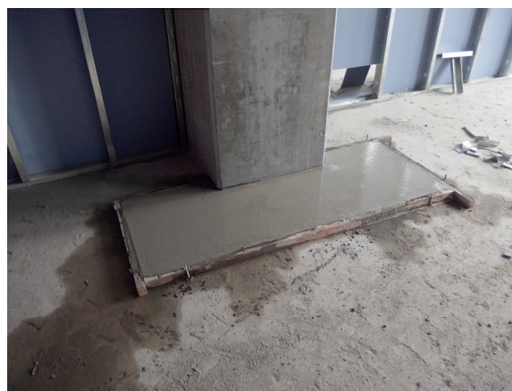
Obr. 2.48 Požární ochrana dodatečné smykové výztuže ve formě zálivky cementovou směsí na horním povrchu (foto archiv autora)
