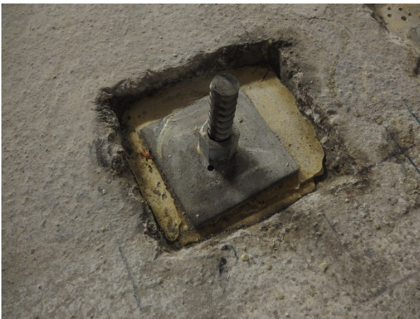
Obr. P 9 Pohled na kotevní desku s injektážním otvorem v desce
