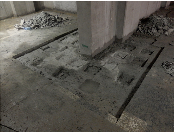
Obr. P 1 Vytvořené kapsy pro sanaci základové desky
