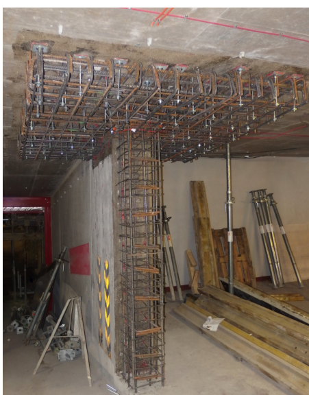
Obr. 5.79 Pohled na armokoš hlavice a prodloužení stěny
