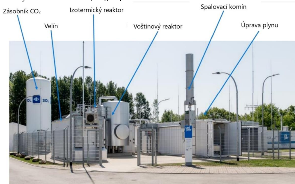
Obrázek 40 Zařízení na výrobu SNG metanizací v Německu [83]
