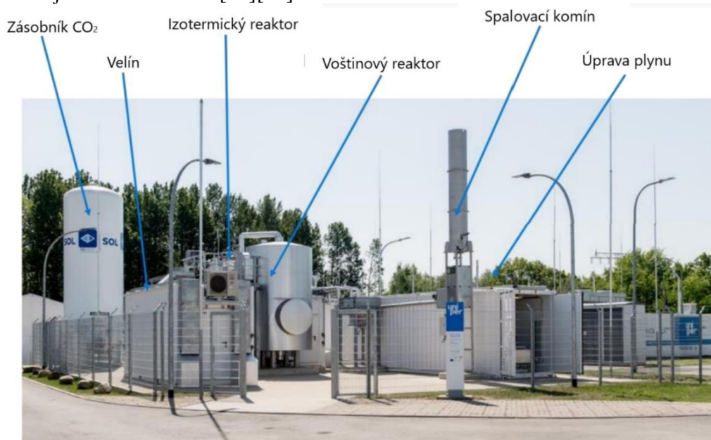
Obrázek 40 Zařízení na výrobu SNG metanizací v Německu [83]
