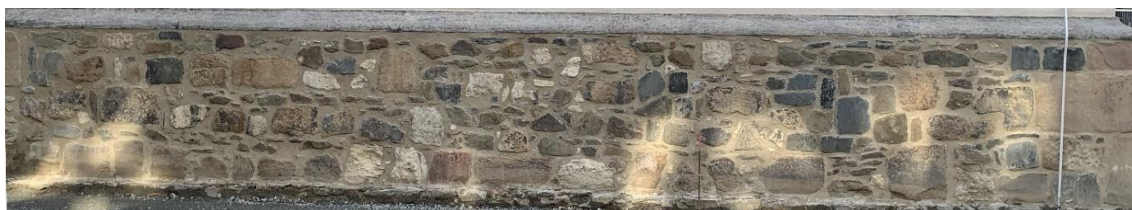
Obr. 15: Severní část soklu severní věže kostela sv. Mořice.
