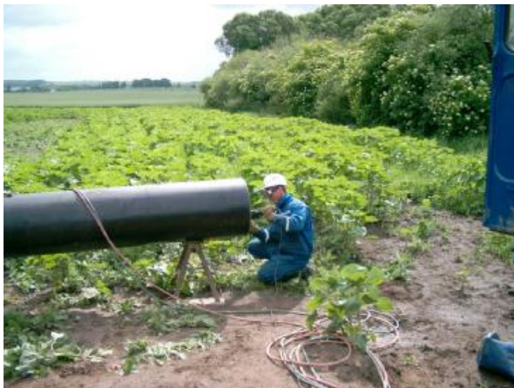
Obr. 2.9 Broušení volného konce nového potrubí
