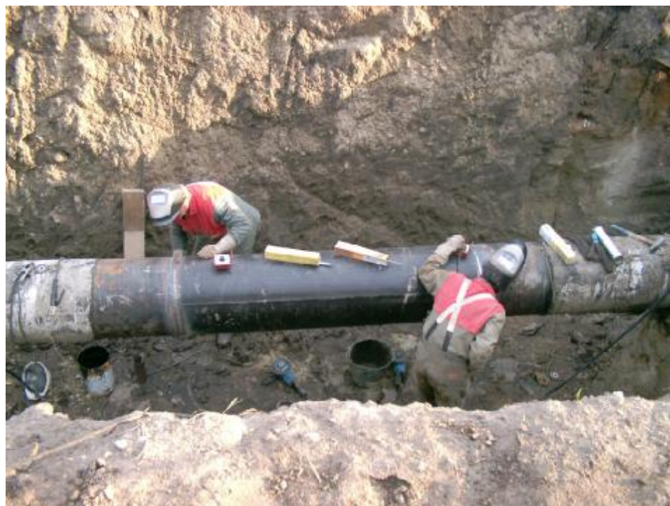
Obr.2.12 Svařování obvodových svarů
