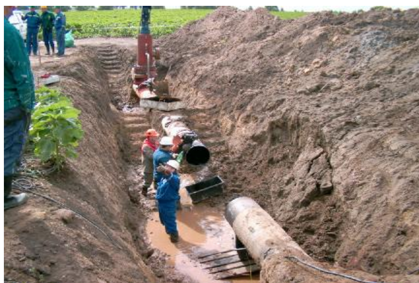
Obr.1.10 Vyříznutá poškozená potrubní část
