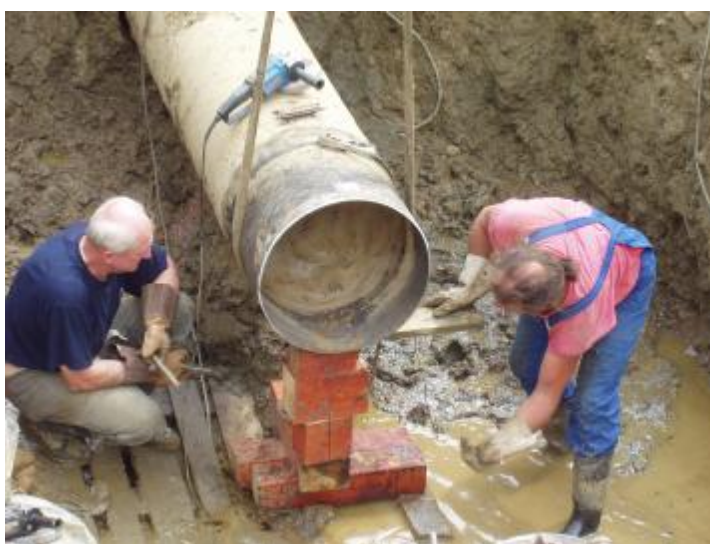
Obr. 2.13 Vyrovnávání sousosti potrubí vypodkládáním
