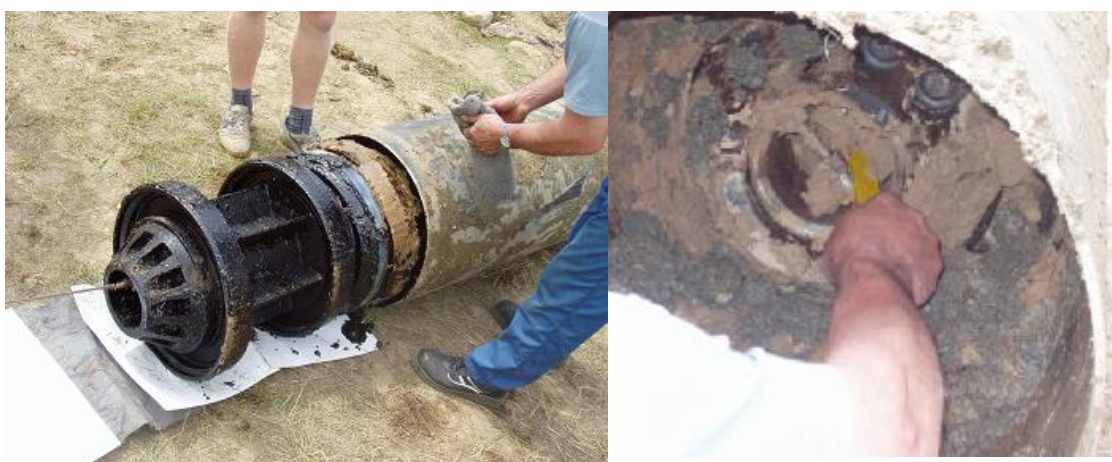
Obr. 2.8 Utěsnění a vyjmutí mechanické ucpávky potrubí
