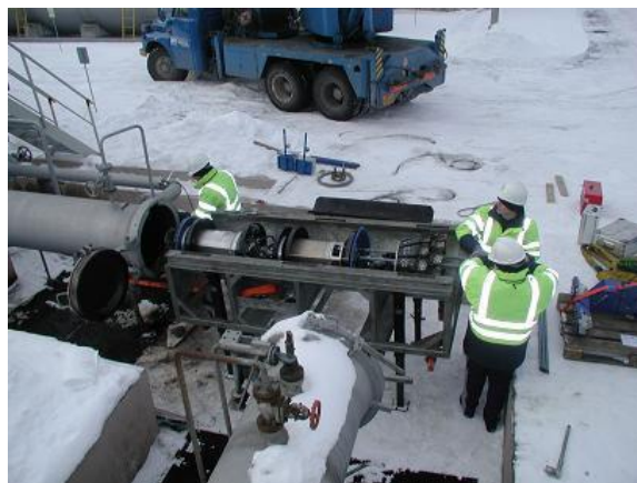
Obr. 1.6 a 1.7 Příprava inspekčního ježka k běhu potrubím [1]
