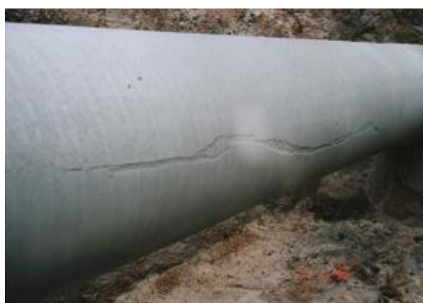
Obr. 1.5 Mechanická drážka na potrubí
