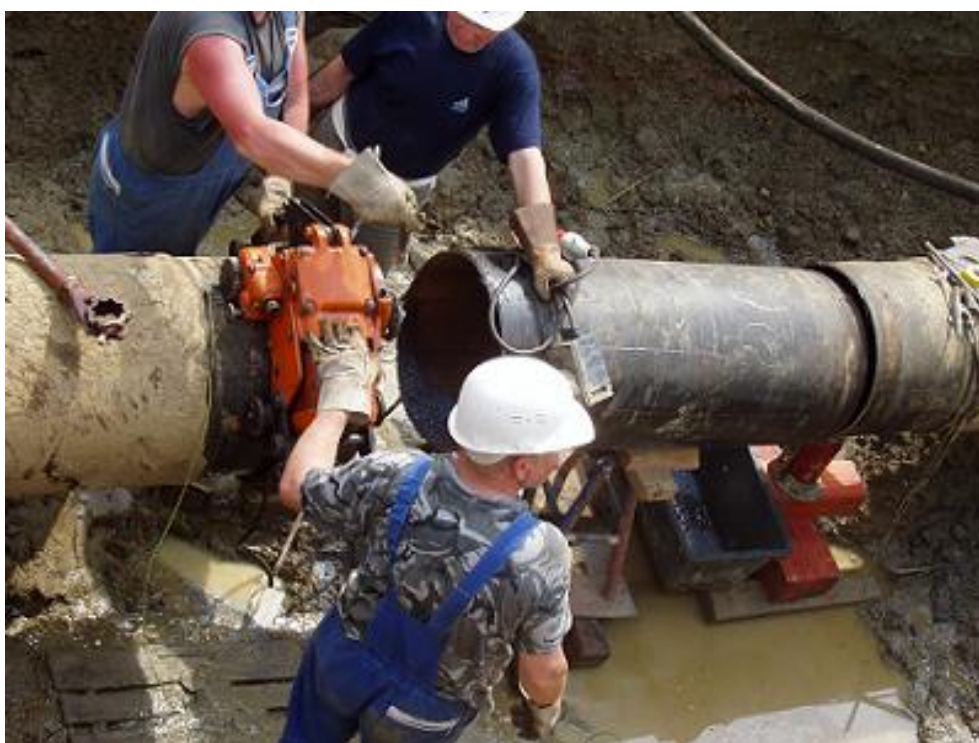
Obr.2.6 Řezání potrubí řezacím strojem s kotoučovou frézou
