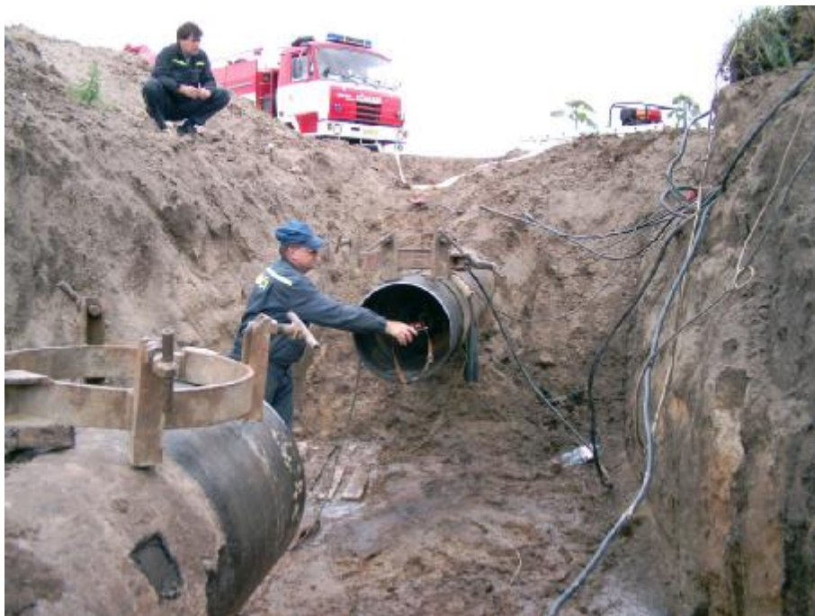
Obr. 2.11 Měření koncentrace výbušných par
