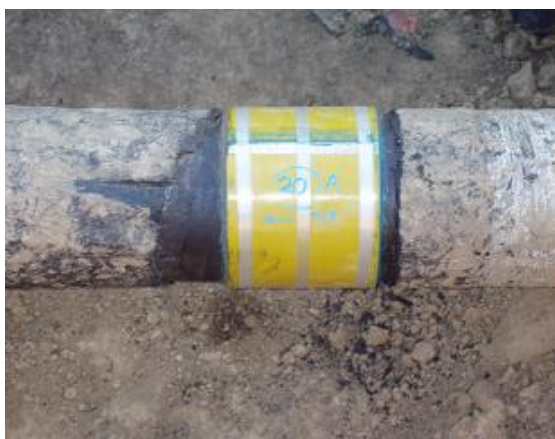
Obr. 1.8 Kompozitní sklolaminátová zesilovací objímka
