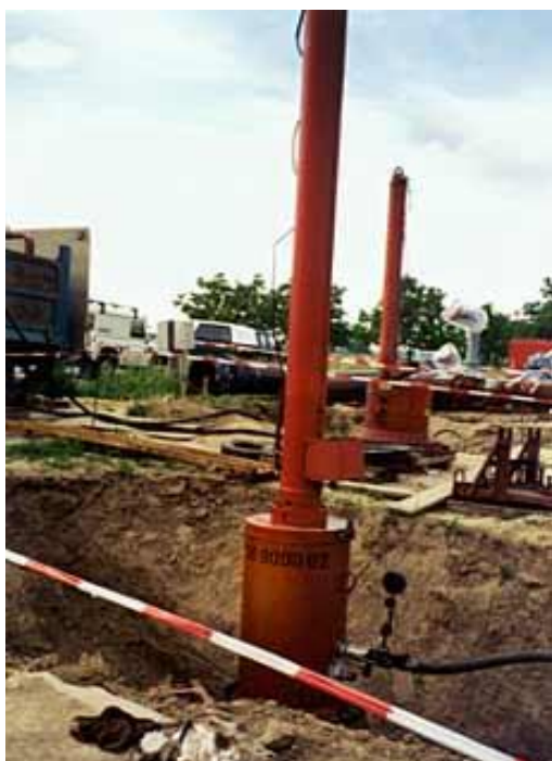
Obr. 2.1 Nainstalovaná „stopplovací“ technika
