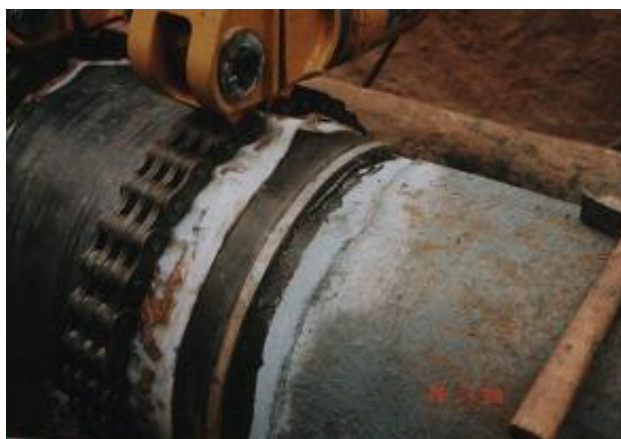
Obr. 1.9 Stahování kovové objímky mech. řetězovou svěrkou
