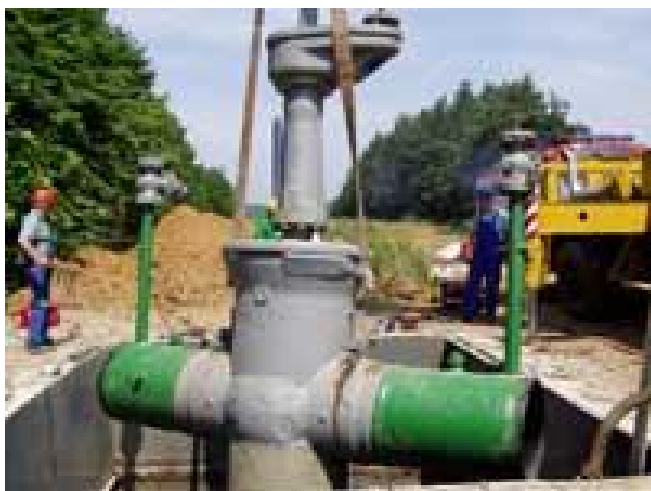
Obr. 1.3 Výměna uzavíracích armatur [1]
