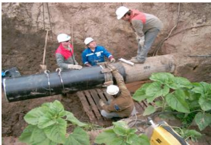
Obr. 2.10 Kontrola usazení nově vkládané části
