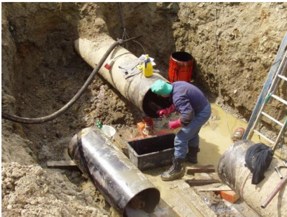
Obr. 2.7 Čištění otevřených konců stávajícího potrubí
