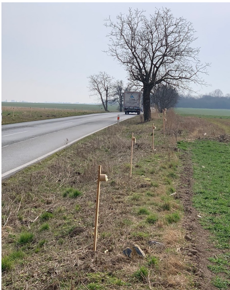
Obrázek 10 Pachové ohradníky na dřevěných latích na silnici č. 101 (Zdroj: vlastní)
