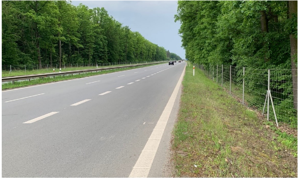
Obrázek 7 Oplocení na I/26 – Sulkovský přivaděč (Zdroj: vlastní)
