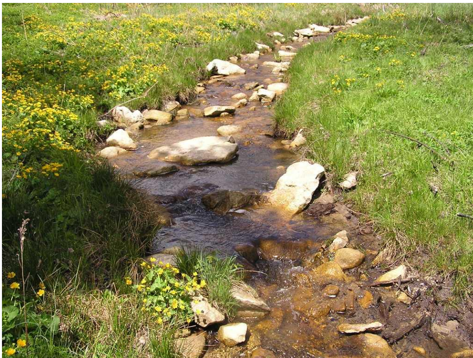
Foto č. 11: Detail opevnění nového koryta kameny (květen 2008)
