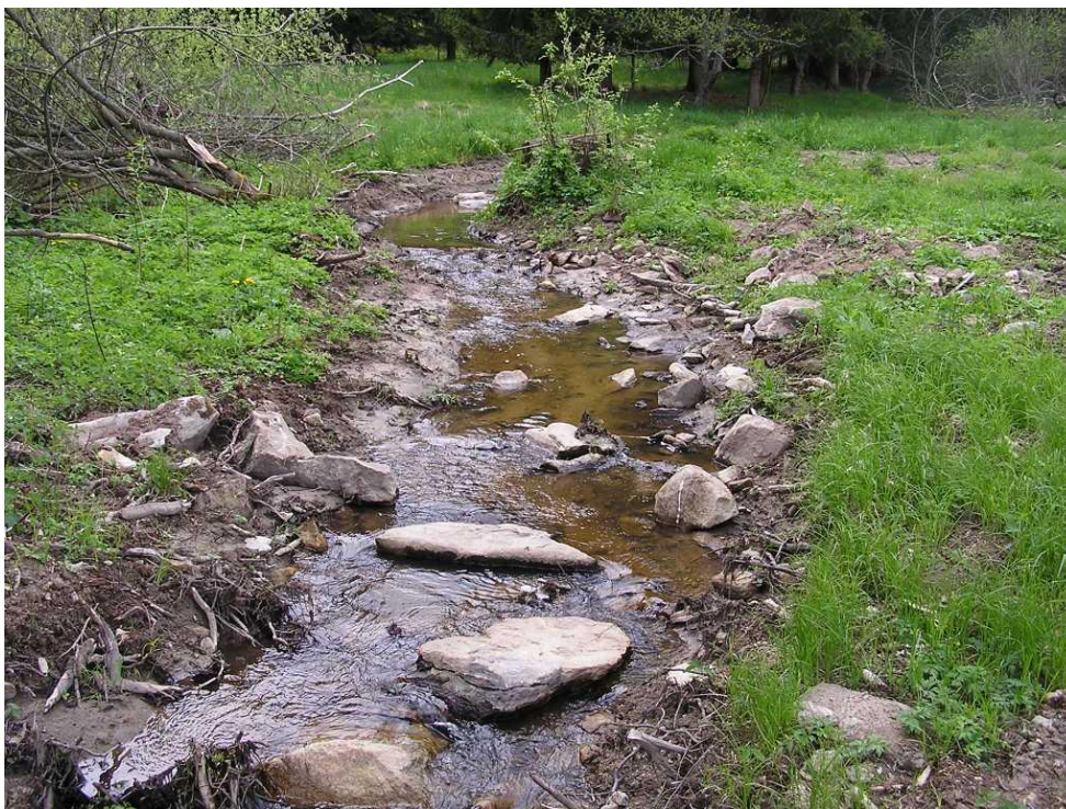
Foto č. 12: Příčný spádový objekt - balvanitý práh (květen 2008)
