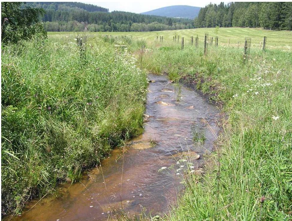
Foto č. 13: Příčný spádový objekt – kamenitý skluz (červen 2008)
