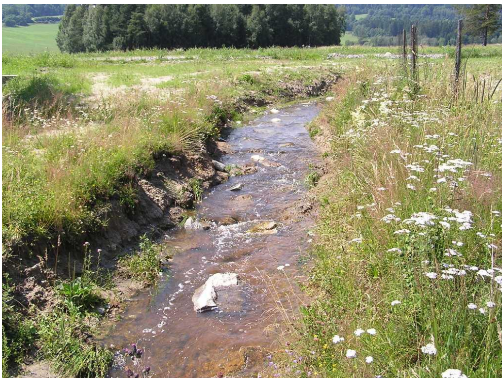
Foto č. 21: Boční eroze koryta toku pod hrází rybníka (červen 2008)
