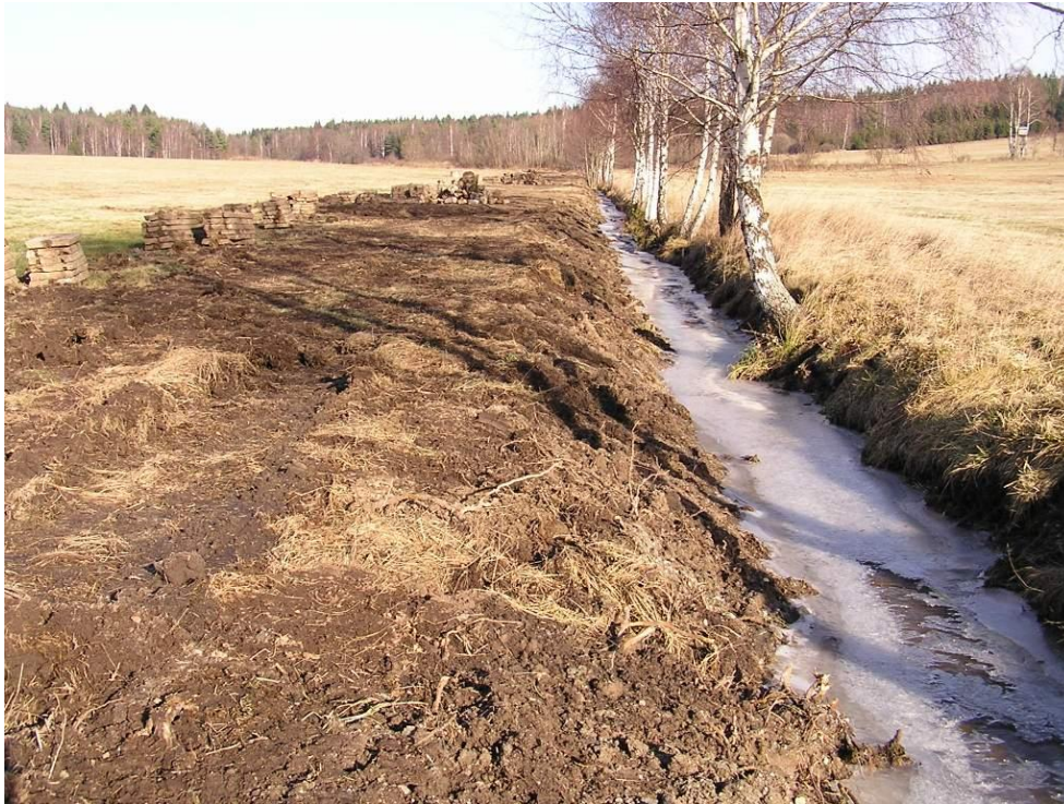
Foto č. 5: Část toku A-1 po odstranění betonových MD desek
