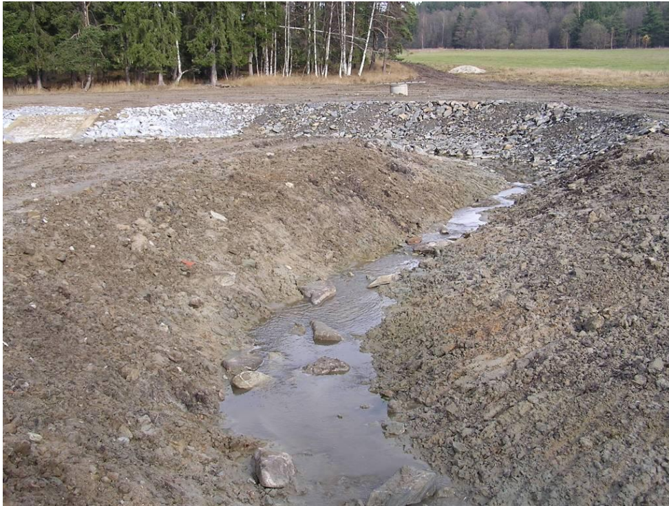
Foto č. 9: Vyústění z rybníka „Hodňovského“ těsně po dokončení prací (duben 2005)
