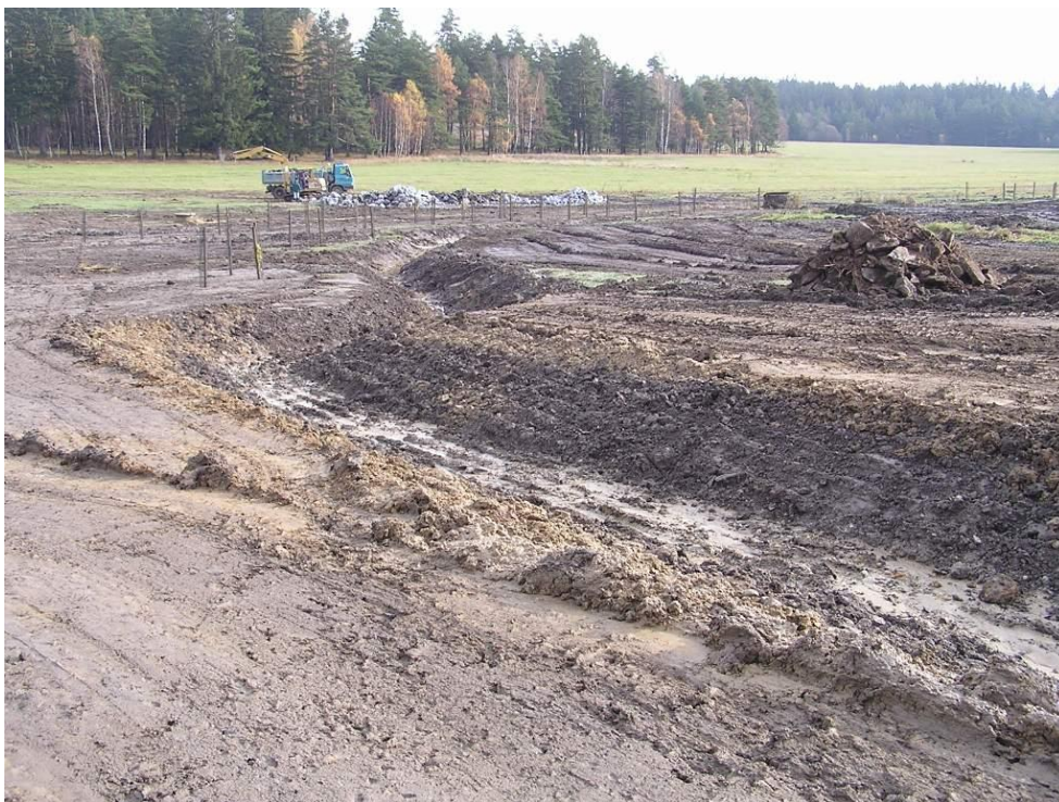
Foto č. 3: Stavba koryta na úseku toku A v nové trase (září, říjen 2005)
