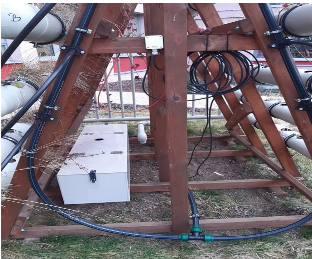
obr. 3 Vertikální zahrada s časovačem, kde je zapojeno dávkování šedou vodou (foto: autor)
