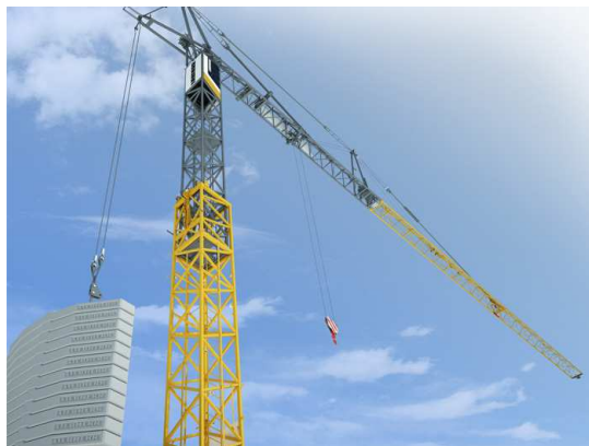
[obr. 22] Věžový jeřáb LIEBHERR 65 K
