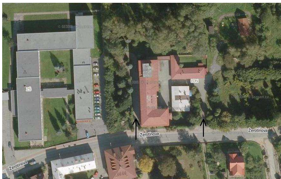
[obr. 2] Vjezd na staveniště
