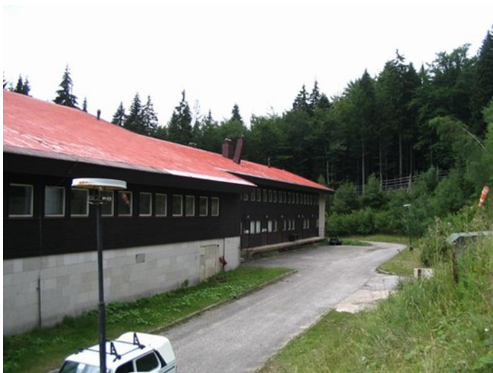
Obr. 5 Objekt úpravny vody – zadní část
