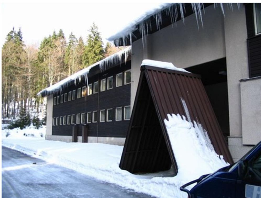
Obr. 3 Objekt úpravny vody – vstup z účelové komunikace
