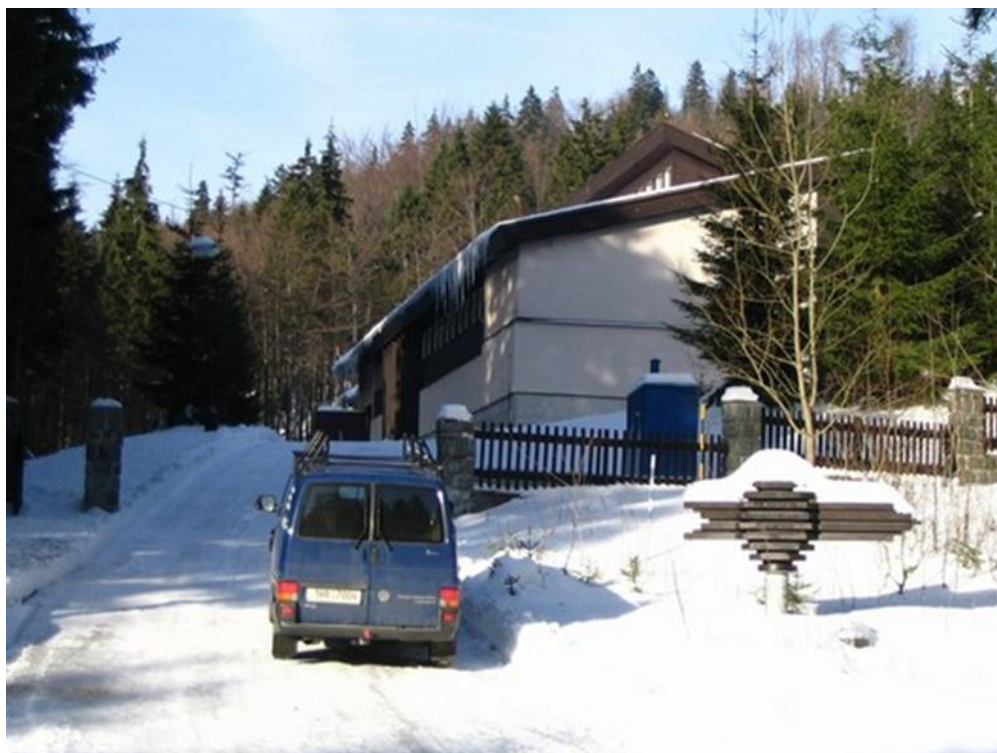
Obr. 4 Objekt úpravny vody – vstupní brána
