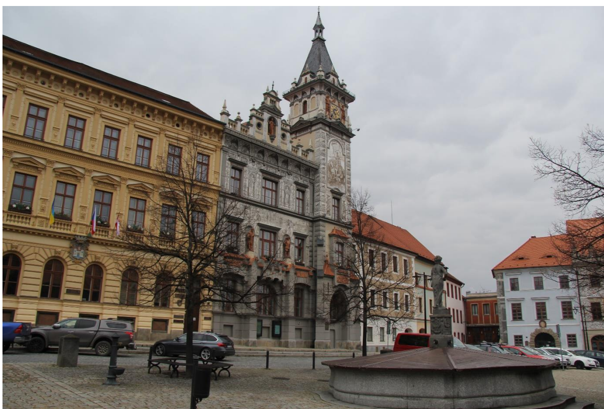
Obrázek 5 - Velké náměstí v Prachaticích (Zdroj: vlastní).
