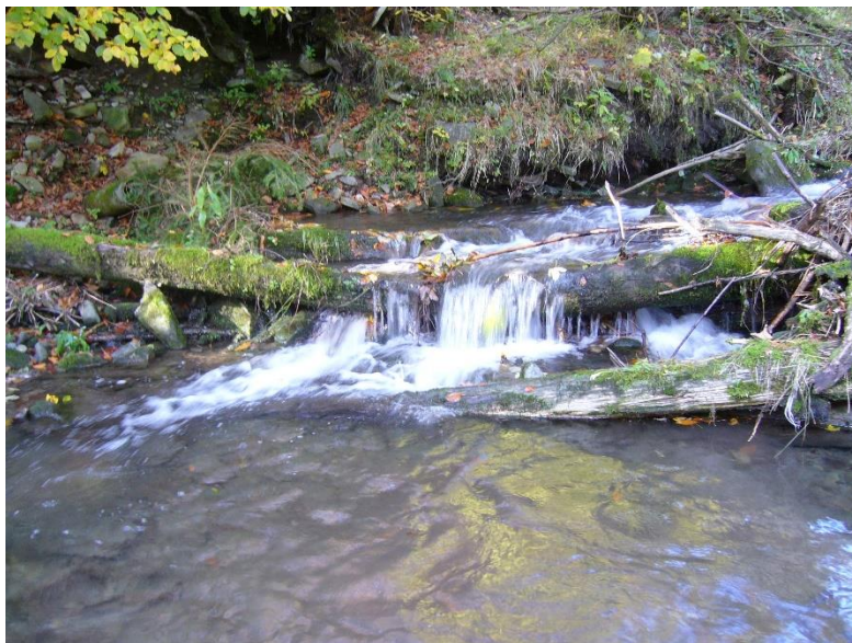
Příloha 1 Polorozbořený stupeň
