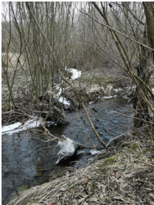
Obr. 40 KP10: Vtok sústredeného odtoku do potoka Drábsko [zdroj: vlastný]
