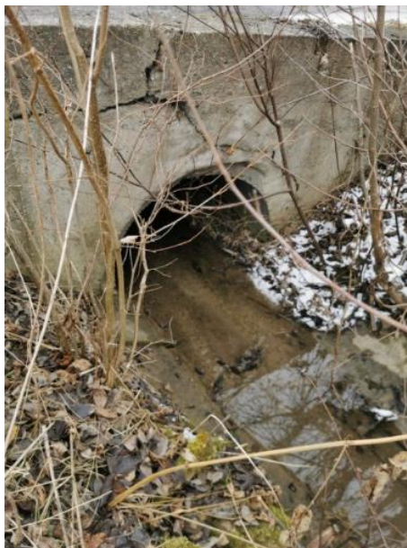
Obr. 36 KP6: Priepust na nepomenovanom toku [zdroj: vlastný]
