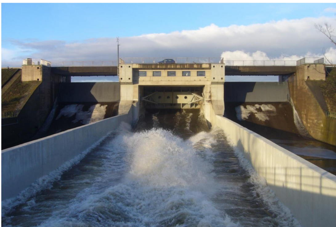
Obrázek 3 – Odpouštění vody Nechranice. dostupné z https://sever.rozhlas.cz/sites/default/files/images/78273d0795c6eab8c901798d106c8db2.jpg
