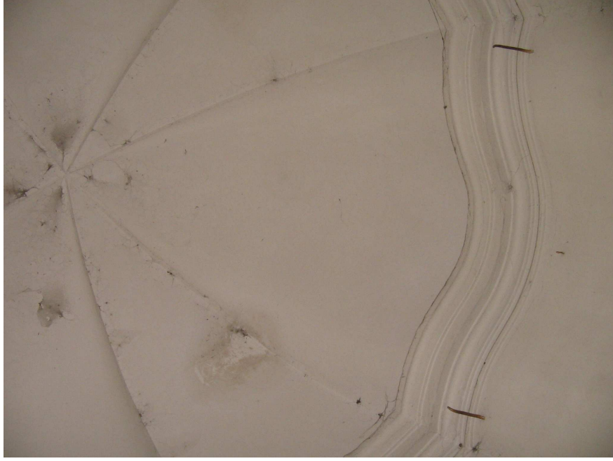
178. Interiér první barokní kaple, 1723 / po 1730, Moravská Třebová, Křížový vrch, přístupová cesta.
