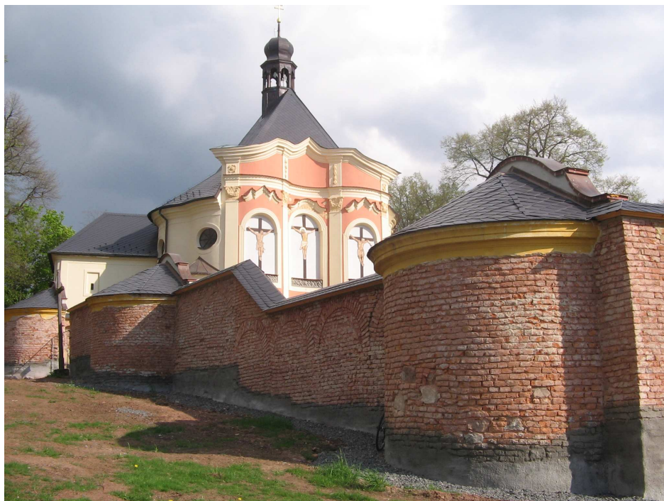
149. Ambity s vystupujícími výklenky kaplí, Jaroměřice u Jevíčka, Kalvárie, pohled od severozápadu.
