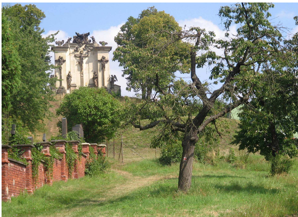
169. Moravská Třebová, Křížový vrch, 1730-1731, přístupová cesta.
