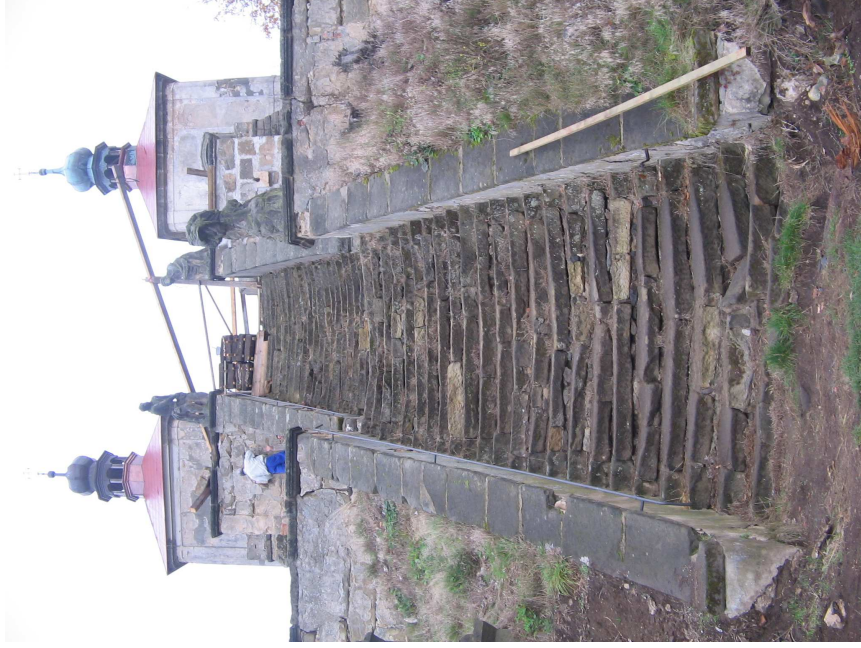
95. Kaple Povýšení sv. Kříže a Nalezení sv. Kříže, stav při opravě (2008), Ostré, Kalvárie, hlavní přístupové schodiště, pohled od západu.
