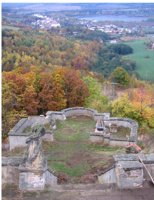
88. Dolní terasa, Ostré, Kalvárie, pohled z první podesty hlavního přístupového schodiště.
