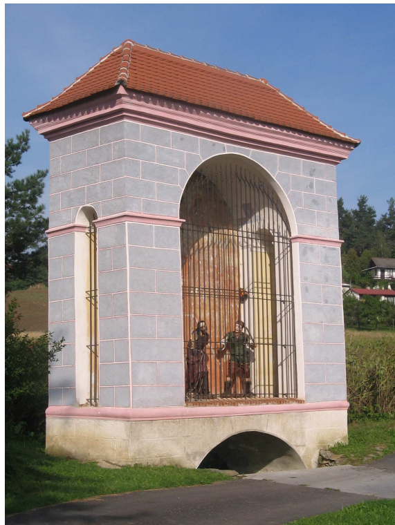
51. Kaple se scénou Krista vedeného přes Cedron, 1658-1670, Římov, 10. zastavení Pašijové cesty.
