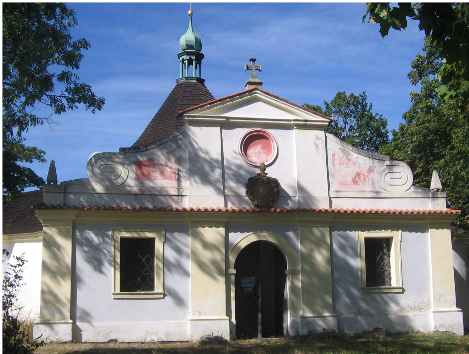
131. Vstupní (jižní) průčelí do areálu, Český Krumlov, Křížová hora.
