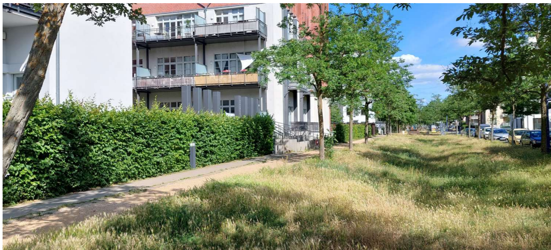
Obr.12 Berlín travnatý průleh pro zasakování vody s lučním společenstvem
