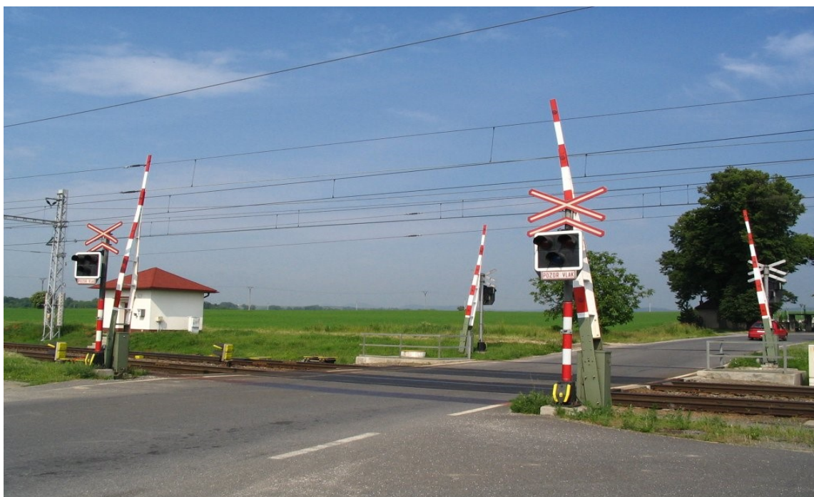
Obr. 2.13 Železniční přejezd zabezpečený mechanickým PZZ
