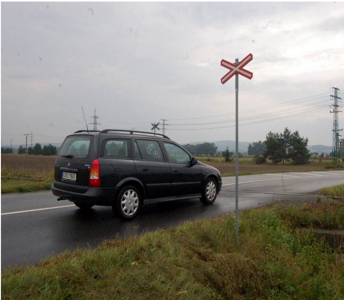
Obr. 2.2 Železniční přejezd označený výstražným křížem
