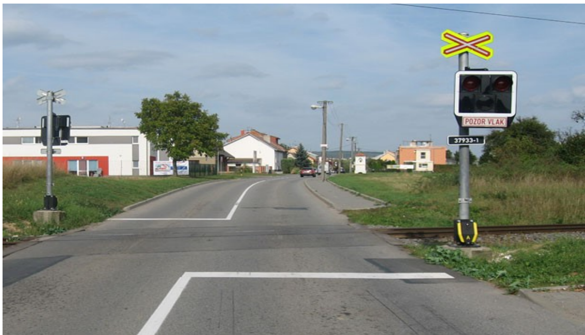
Obr. 2.14 Železniční přejezd zabezpečený světelným PZZ bez závor
