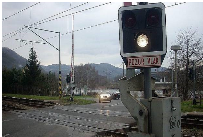
Obr. 2.11 Pozitivní signalizace na železničním přejezdu
