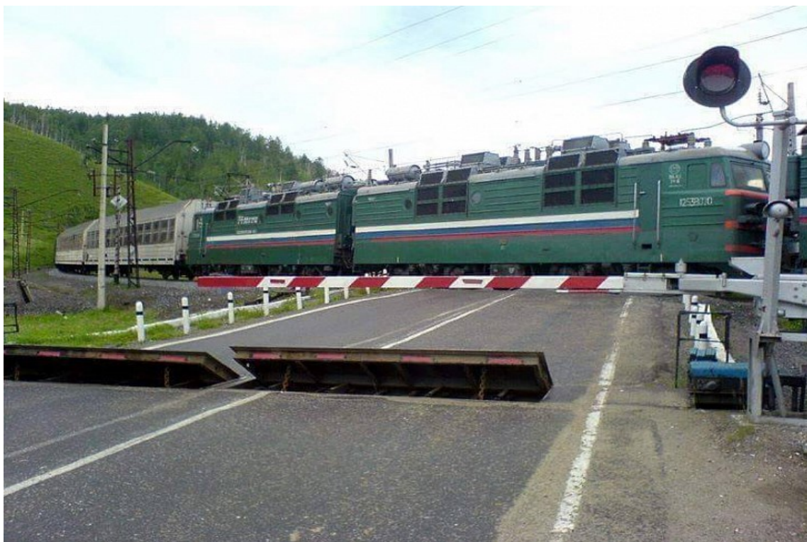
Obr. 3.1 Výklopné desky ve vozovce
