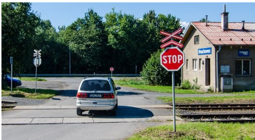
Obr. 2.12 Přejezd zabezpečený pouze výstražným křížem
