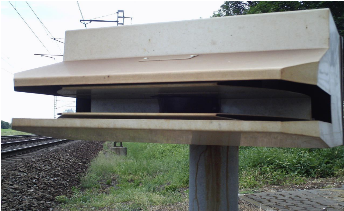
Obr. 3.2 Namontovaný laserový skener s krytem na železničním přejezdu
