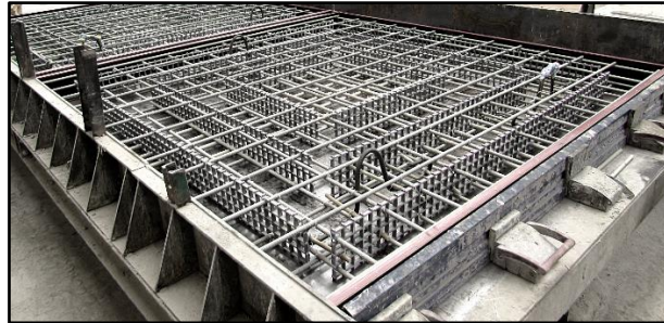
Obr. 7 Kompozitní výztuž zákrytové desky v bednění před betonáží
