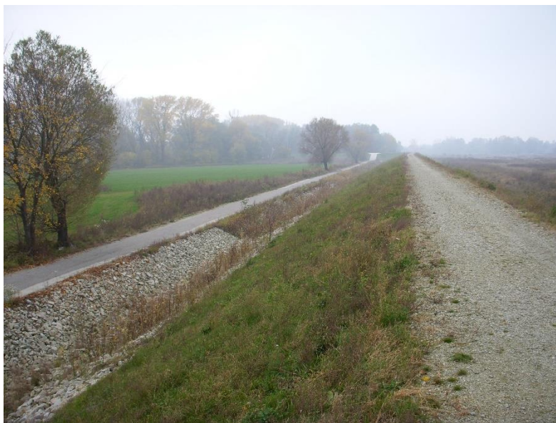
Obrázek 9 Ochranná hráz v lokalitě Bratislava – Děvínská Nová Ves, vodní tok Morava [10, s. 40]
