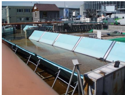
Obrázek 19 Šikmý deskový systém [10]
