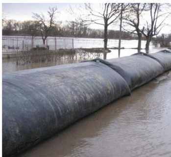
Obrázek 21 Pryžotextilní vaky plněné vodou [10]
