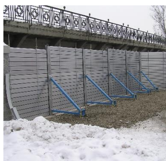
Obrázek 12 Svislé hradidlové systémy [10]
