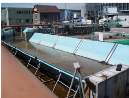
Obrázek 19 Šikmý deskový systém [10]
