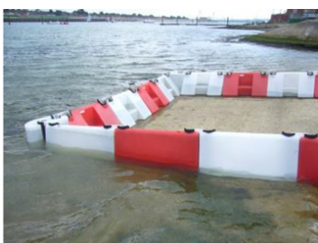
Obrázek 20 Zábrany z plastových modulů [10]
