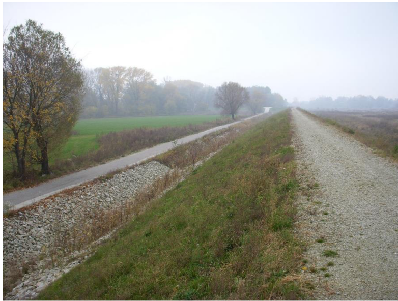
Obrázek 9 Ochranná hráz v lokalitě Bratislava – Děvínská Nová Ves, vodní tok Morava [10, s. 40]
