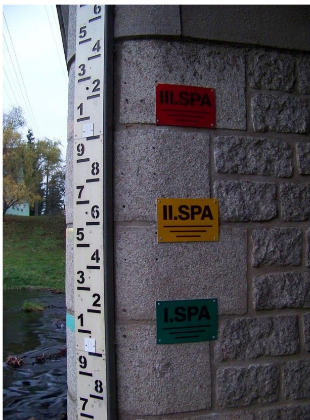
Obrázek 5 Označení stupňů povodňové aktivity u vodočtu na pilíři mostu přes řeku Moravu v Olomouci-Chomoutově [36]
