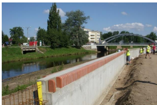
Obrázek 10 Výstavba železobetonové vetknuté povodňové zdi v lokalitě Veselí nad Lužnicí [10, s. 41]
