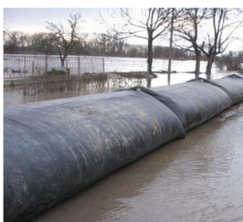
Obrázek 21 Pryžotextilní vaky plněné vodou [10]
