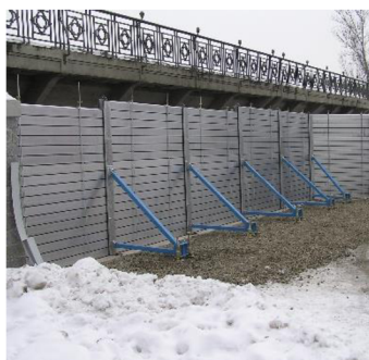
Obrázek 12 Svislé hradidlové systémy [10]
