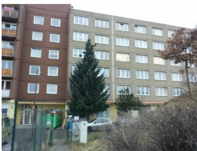
Obr. 5: Domov mládeže - pohled z přední části (vlastní zpracování)
