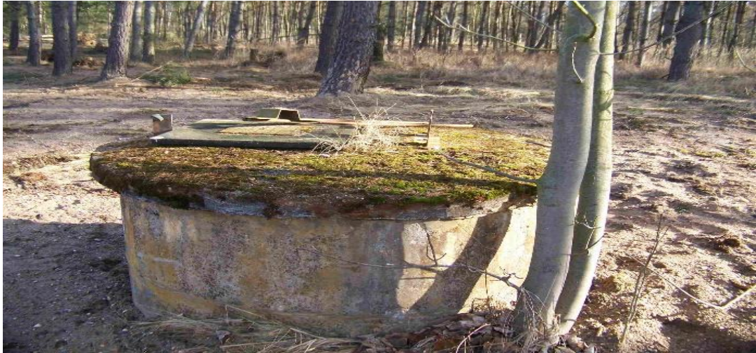
Obrázek 7: Pohled na původní jímací objekt (zdroj: vlastní)
