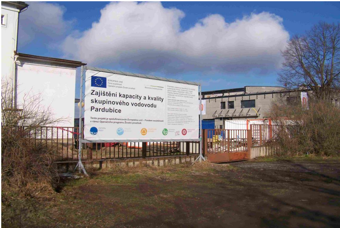
Obrázek 3: Pohled na úpravnu vody Hrobice, kde probíhá její intenzifikace (zdroj: vlastní)
