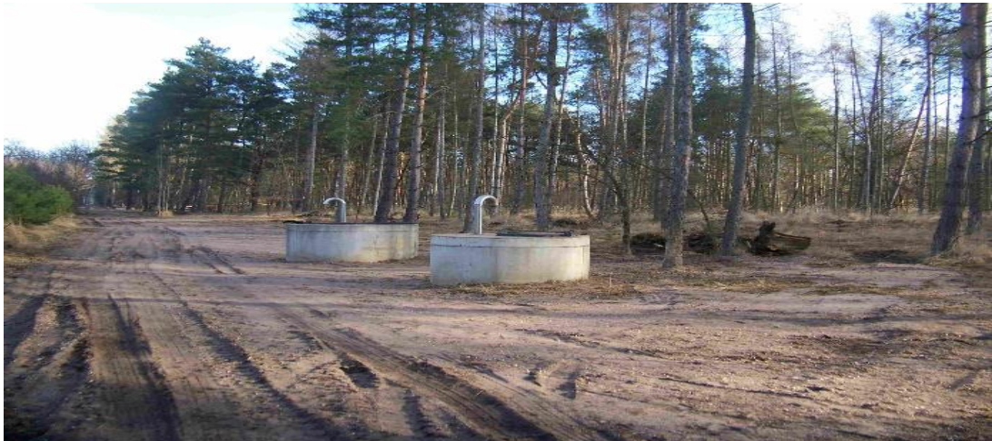
Obrázek 8: Rekonstruovaný jímací objekt – pohled na jejich upravenou nadzemní část (zdroj: vlastní)
