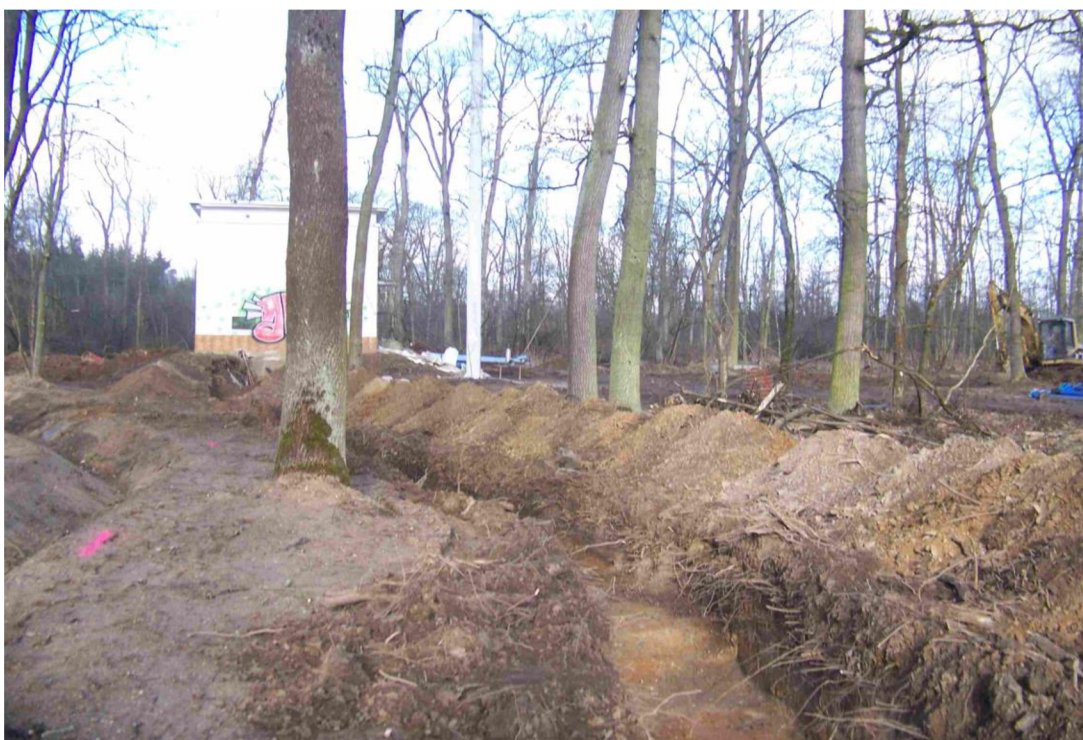
Obrázek 10: Pohled na okolí čerpací stanice, kde v současné době probíhají zemní práce související s rekonstrukcí výtlačného řadu a přílehlého systému povrchového odvodnění realizovaného v areálu vodního zdroje (zdroj: vlastní)
