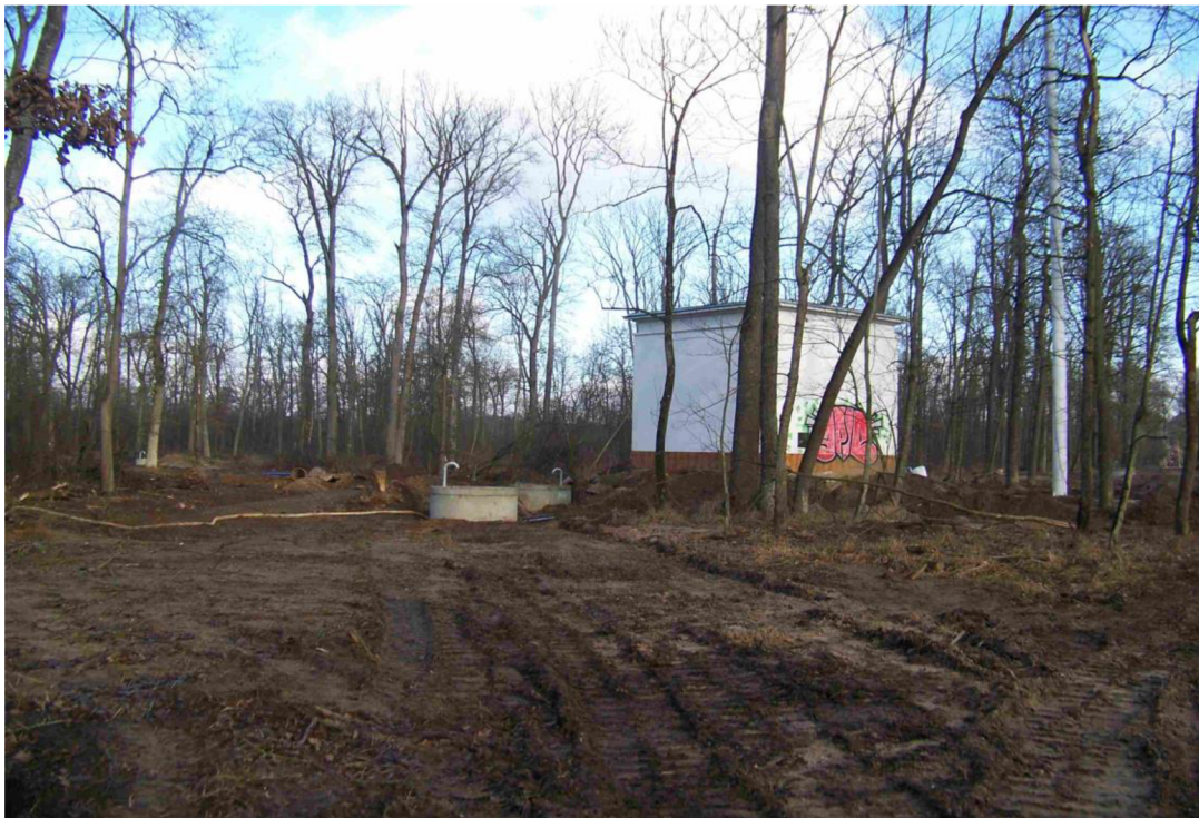
Obrázek 9: Pohled na objekt čerpací stanice, kde v současné době probíhají stavební práce v rámci intenzifikace vodního zdroje (zdroj: vlastní)
