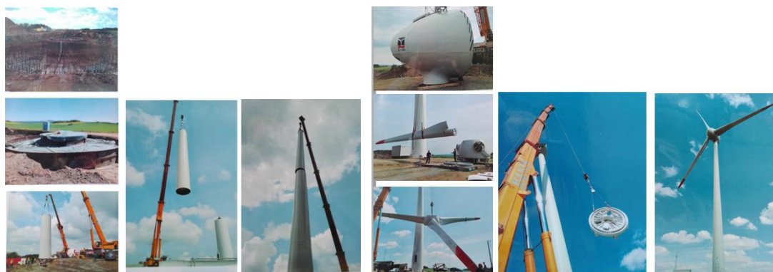
Obr. 24: Proces výstavby větrné elektrárny Dožice
