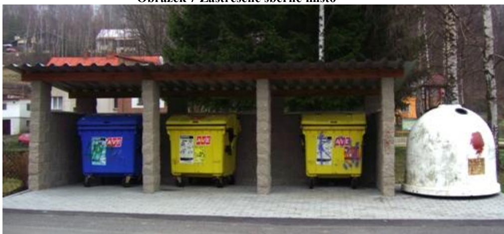
Obrázek 7 Zastřešené sběrné místo
