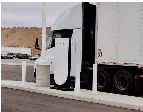
Obr. 30 Stanice Megacharger vybudovaná při Tesla Motors Nevada [74]
