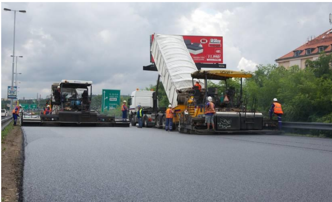
Obrázek 1: Pokládka směsi VIAPHONE, Praha, ul. 5. května (5)
