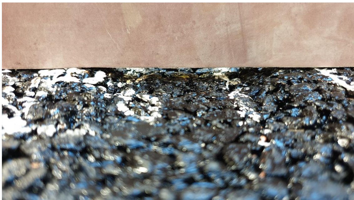
Obrázek 36: Detail vyjeté koleje (30)
