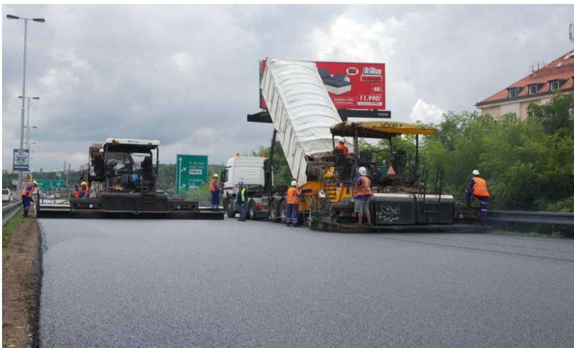
Obrázek 1: Pokládka směsi VIAPHONE, Praha, ul. 5. května (5)
