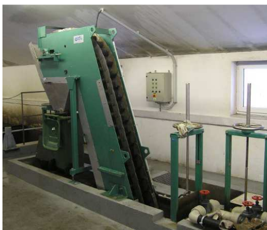
Obr. 3: Příklad čištění pomocí česlí [19]
