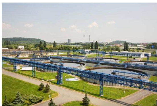
Obr. 1: Čistírna odpadních vod [4]
