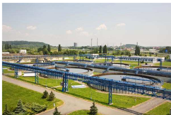
Obr. 1: Čistírny odpadních vod [4]
