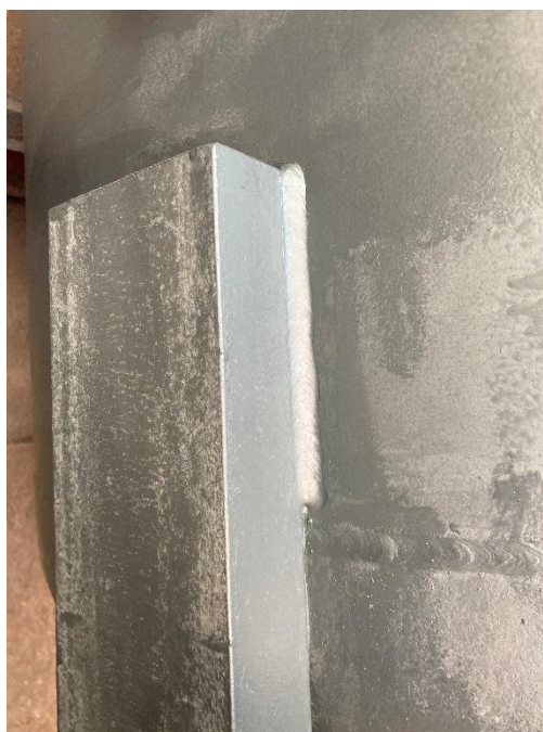
Obr.2.4-2 Svarový spoj nohy a pláště
