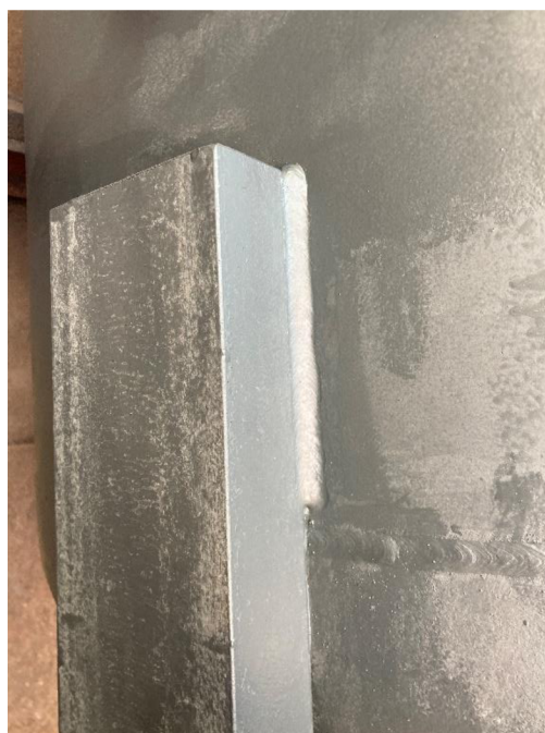
Obr.2.4-2 Svarový spoj nohy a pláště
