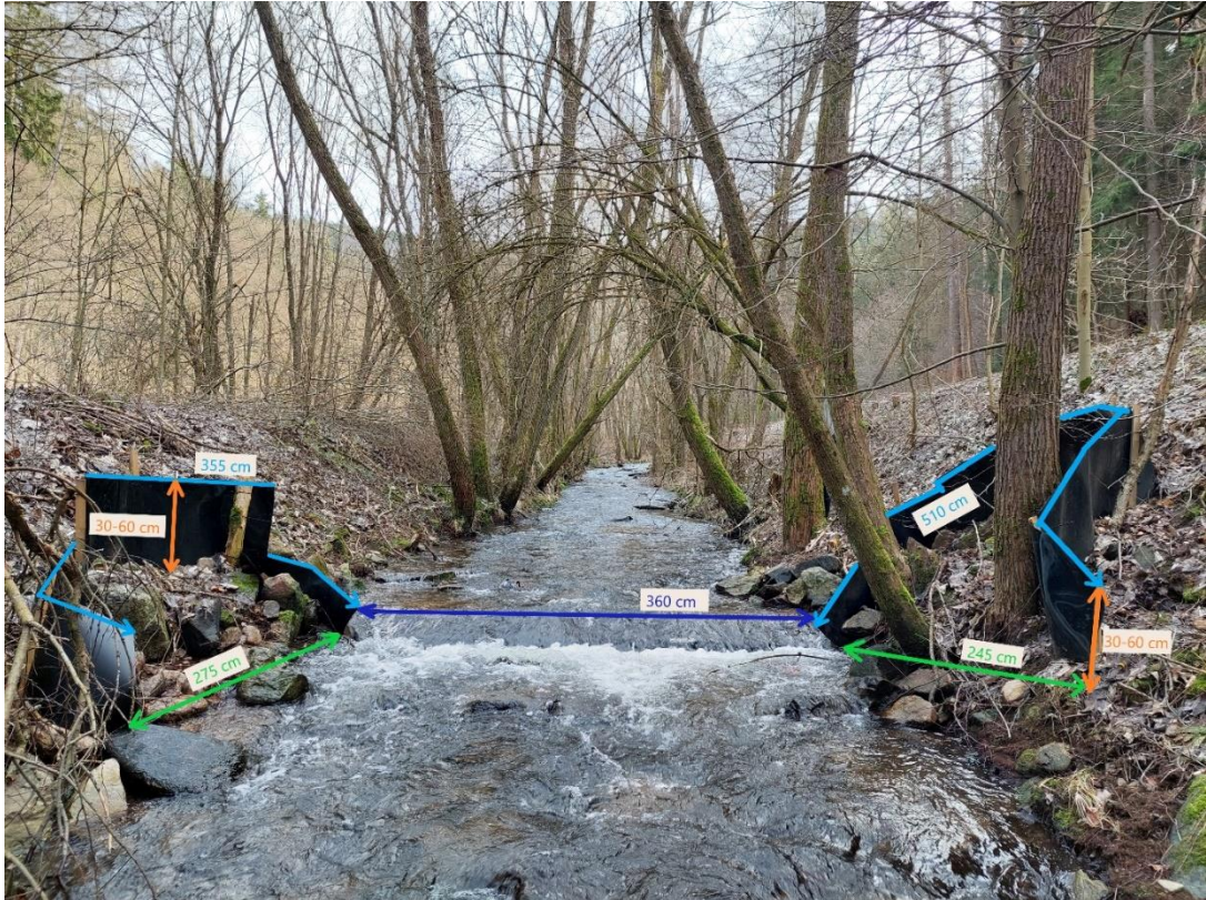
Obr. 9: Rozměry bariér na horním jezu (Šrytrová 26.02.2024)
