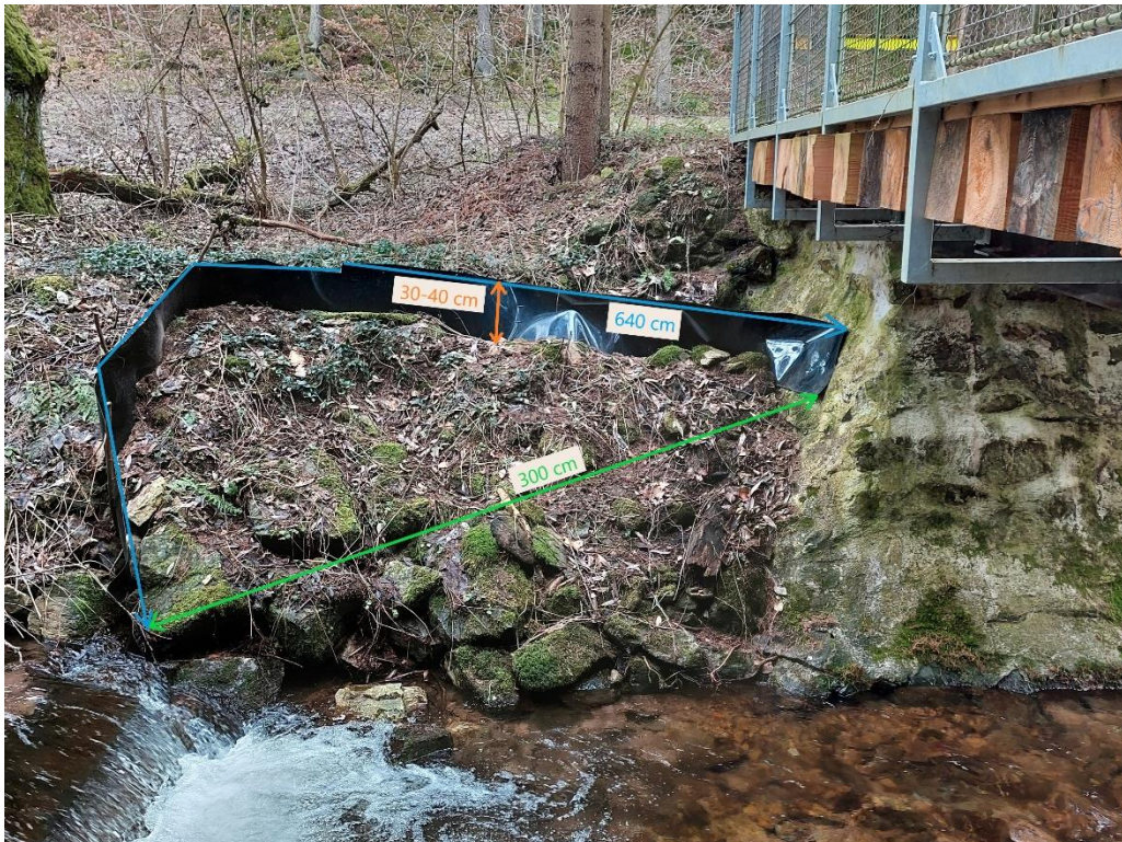
Obr. 12: Rozměry bariér na spodním jezu, pohled na levý břeh (Šrytrová 26.02.2024)
