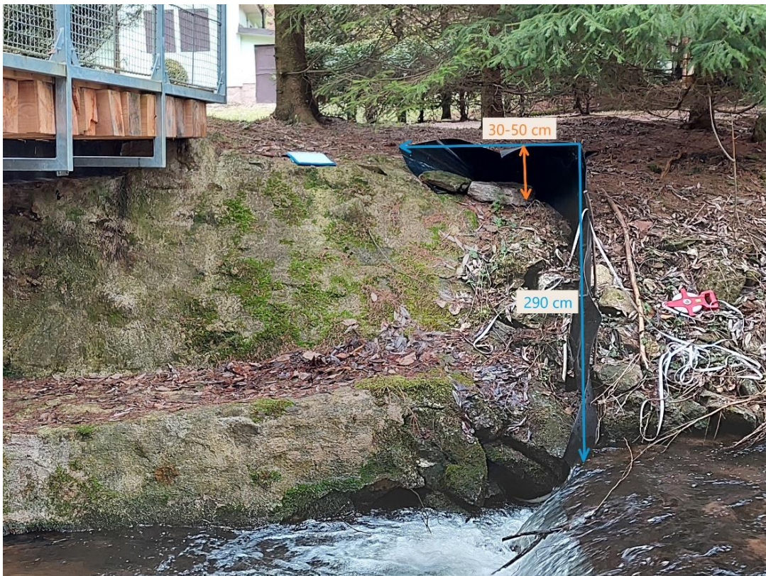
Obr. 10: Rozměry bariér na spodním jezu, pohled na pravý břeh (Šrytrová 26.02.2024)
