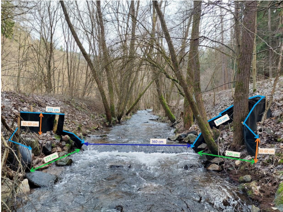
Obr. 9: Rozměry bariér na horním jezu (Šrytrová 26.02.2024)
