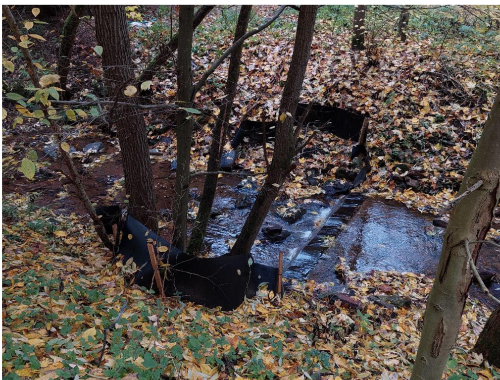
Obr. 8: Instalované překážky na horním jezu, pohled ze břehu (Šrytrová 31.10.2023)
