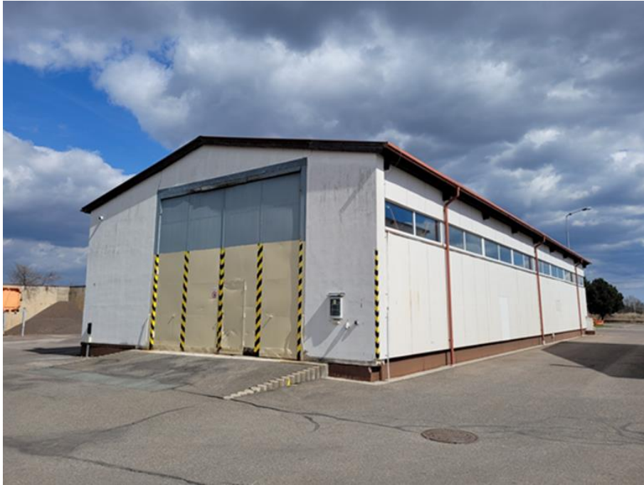
Obr. 4.10 Venkovní pohled na halu s posypovou solí
