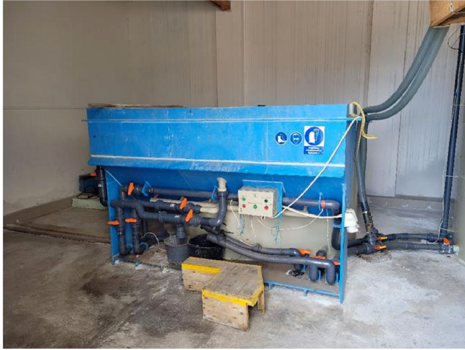
Obr. 4.12 Míchací zařízení na výrobu solanky
