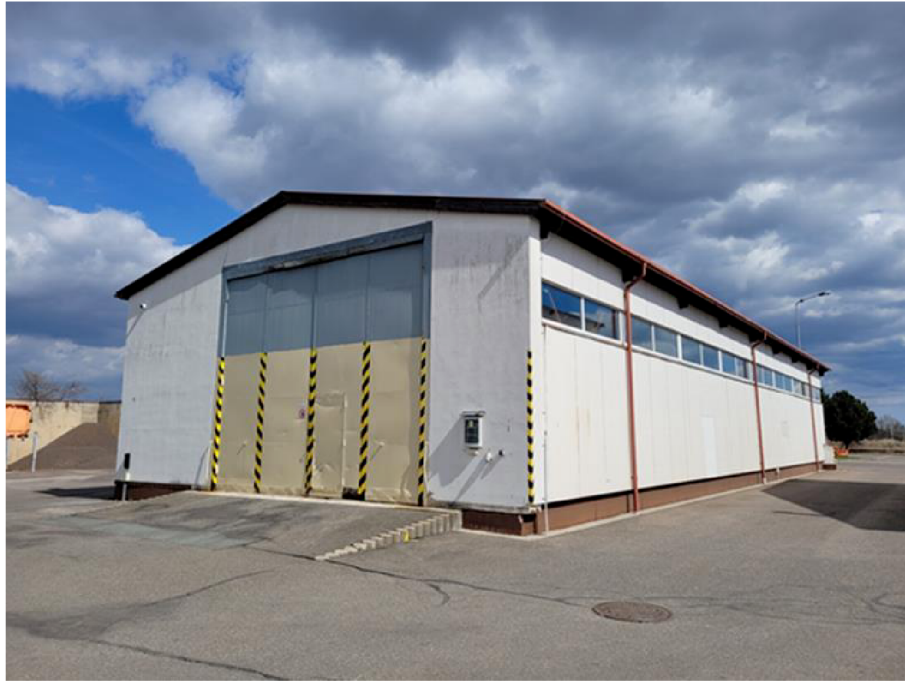
Obr. 4.10 Venkovní pohled na halu s posypovou solí
