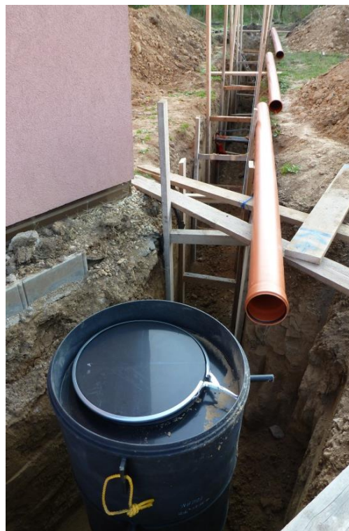
Obr. 6.13: Příprava na pokládku spodního potrubí, vepředu kontrolní šachta „š-2“ – foto: autor
