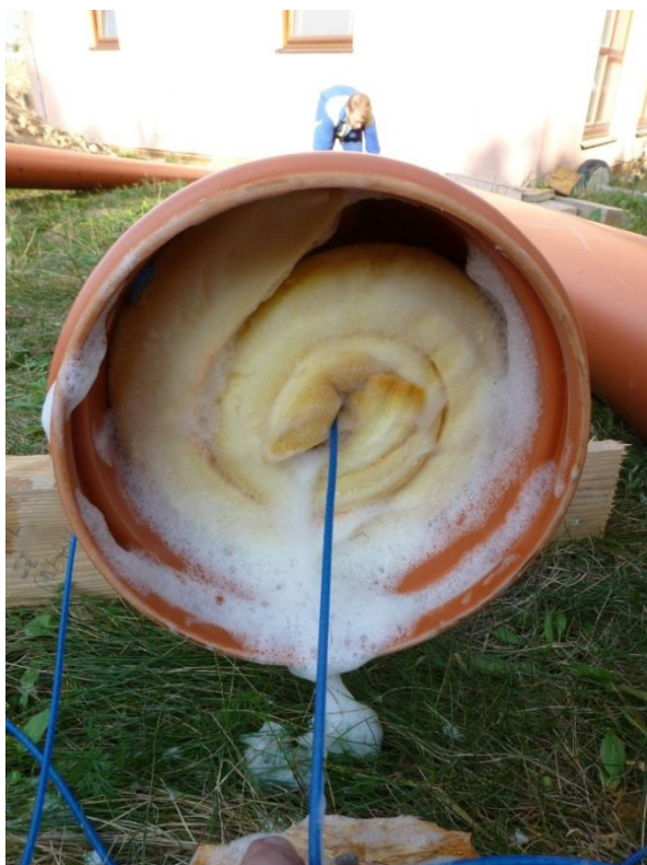
Obr. 6.10: Čištění potrubí před pokládkou; foto: autor
