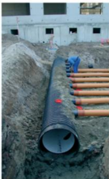
Obr. 3.19: Sběrné potrubí zemního registru (foto z instalace [37])
