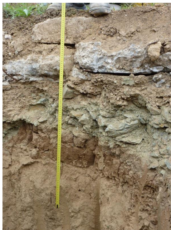
Obr. 6.9: Skladba zeminy v blízkém okolí horní/nasávací šachty „š-1“, patrná je nesourodost prvních cca 0,5 m zeminy pod povrchem – foto: autor –
