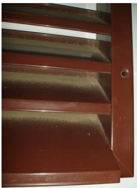
Obr. 8.12: Zašpiněná fasádní žaluzie na konci jara (patrné nánosy pylových částic) – foto: autor
