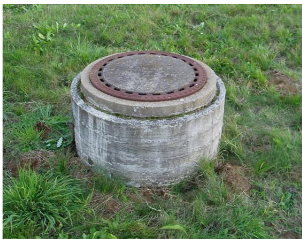
Obr. 8.2: Příklady použitých řešení nasávání vzduchu do ZVT – vlevo: ZVT č. 3, vpravo: ZVT č. 7 (foto: autor)
