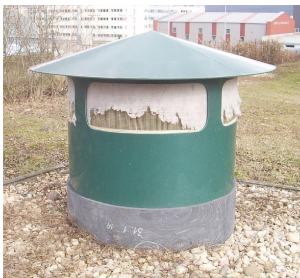
Obr. 8.6: Nasávací hlavice experimentálního zemního výměníku FSI VUT s dvojitou filtrací vzduchu (foto: autor)
