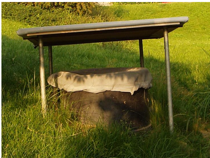
Obr. 8.1: Příklady použitých řešení nasávání vzduchu do ZVT – vlevo: ZVT č. 6, vpravo: ZVT č. 20 (foto: autor)
