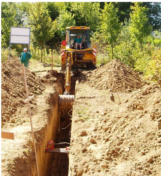
Obr. 6.8: Realizace výkopových prací ZVT (v popředí jsou vidět kabely pro napájení osvětlení sousedícího sportovní areálu VUT v Brně; foto: autor
