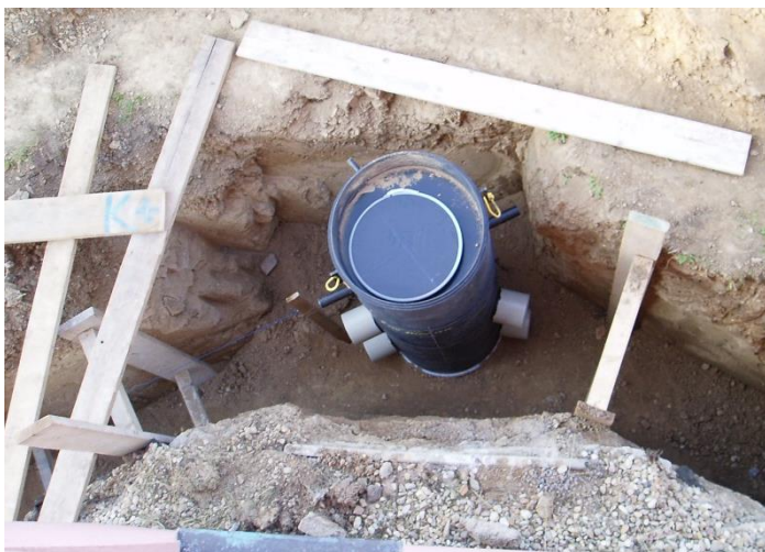
Obr. 6.12: Usazování kontrolní šachty „š-2“; foto: autor
