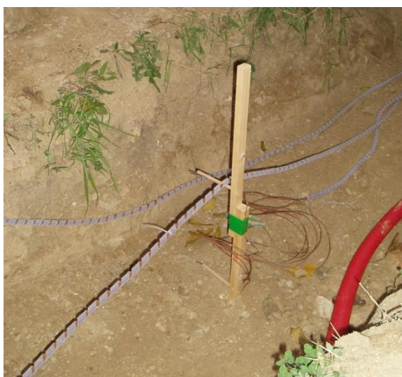
Obr. 6.14: Pokládka plastové chráničky pro čidla TRHx z nasávací šachty „š-1“ a teplotních sond „A“, „B“ a „C“
