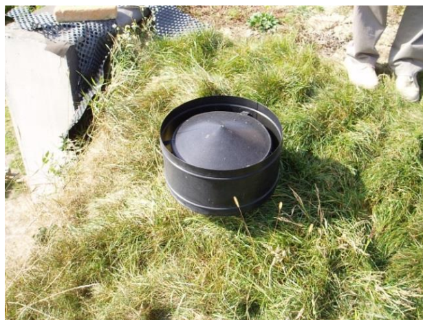
Obr. 8.2: Příklady použitých řešení nasávání vzduchu do ZVT – vlevo: ZVT č. 3, vpravo: ZVT č. 7 (foto: autor)
