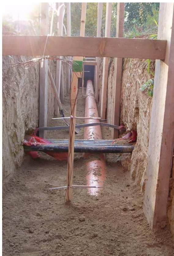
Obr. 6.7: Usazená zemní sonda „B“ (v pozadí je patrná zadní – nasávací šachta a sonda „A“); foto: autor
