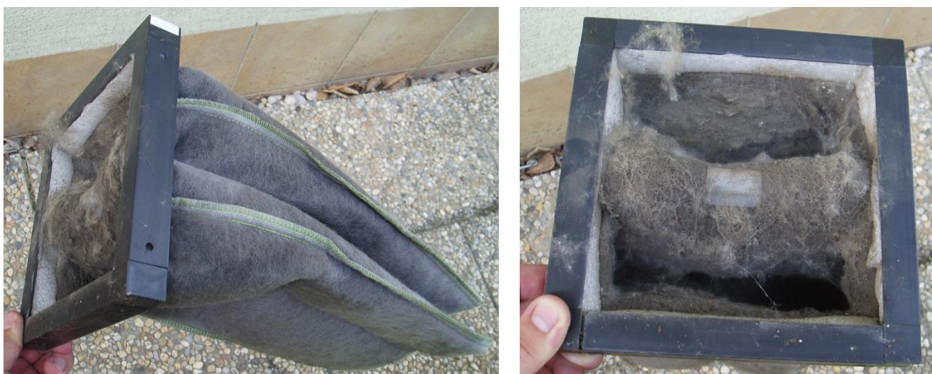
Obr. 8.7: Výměnný kapsový filtr na sání ZVT č. 19 po několikaletém provozu – foto: autor
