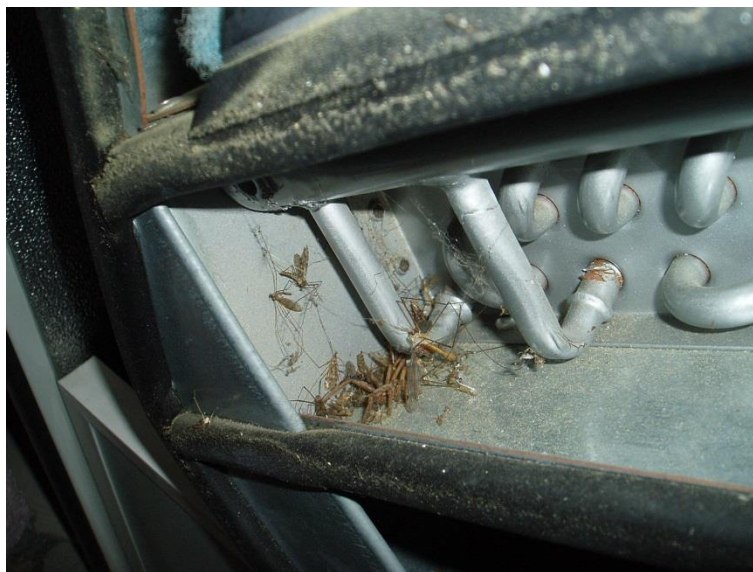
Obr. 8.15: Biologické znečištění ohřívače ve VZT jednotce – foto: autor
