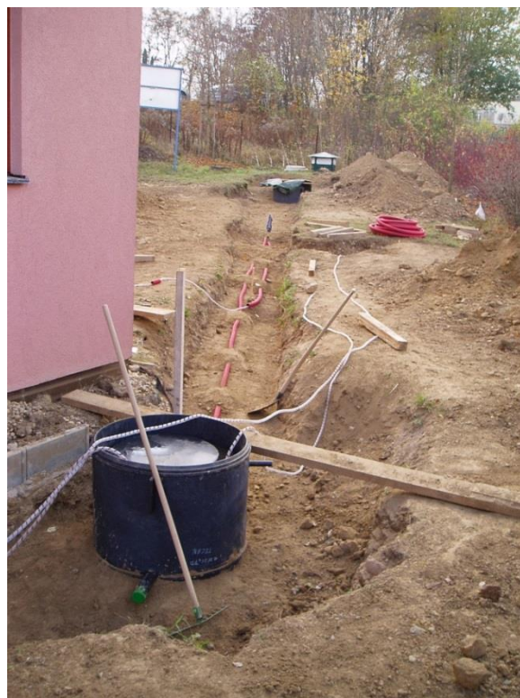
Obr. 6.14: Pokládka plastové chráničky pro čidla TRHx z nasávací šachty „š-1“ a teplotních sond „A“, „B“ a „C“
