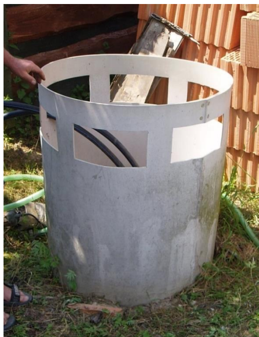
Obr. 8.3: Příklady použitých řešení nasávání vzduchu do ZVT – vlevo: ZVT č. 2, vpravo: ZVT č. 16 a 17 (foto: autor)
