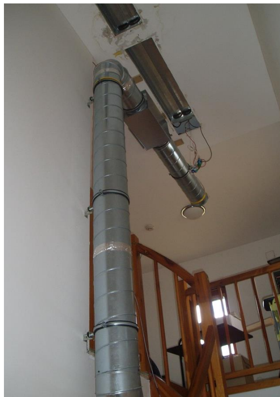
Obr. 6.17: Sání cirkulačního vzduchu z haly ve 2.NP (foto: autor)
