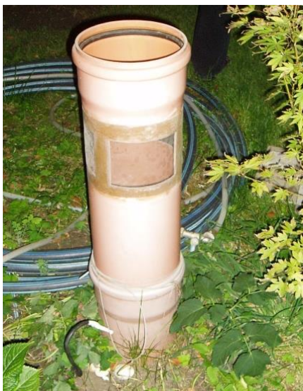
Obr. 8.1: Příklady použitých řešení nasávání vzduchu do ZVT – vlevo: ZVT č. 6, vpravo: ZVT č. 20 (foto: autor)
