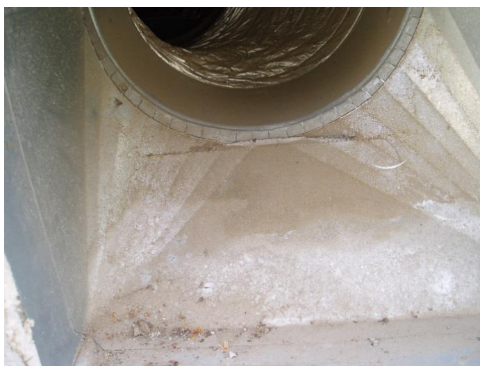
Obr. 8.15: Biologické znečištění ohřívače ve VZT jednotce – foto: autor
