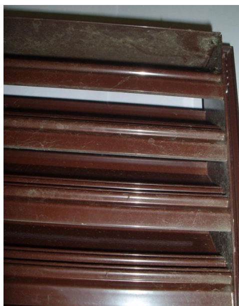
Obr. 8.12: Zašpiněná fasádní žaluzie na konci jara (patrné nánosy pylových částic) – foto: autor
