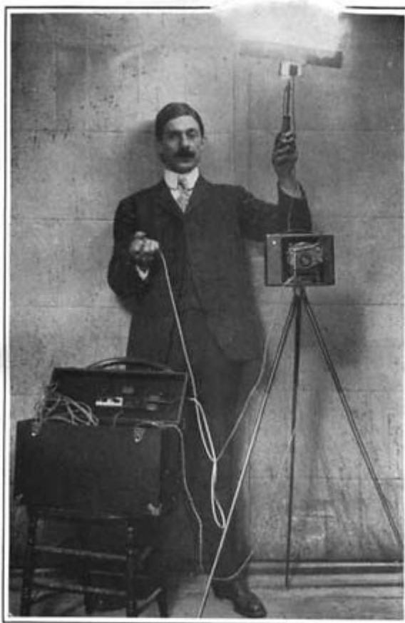
Obr. 23 Blesk na bázi bleskového prášku [25]
